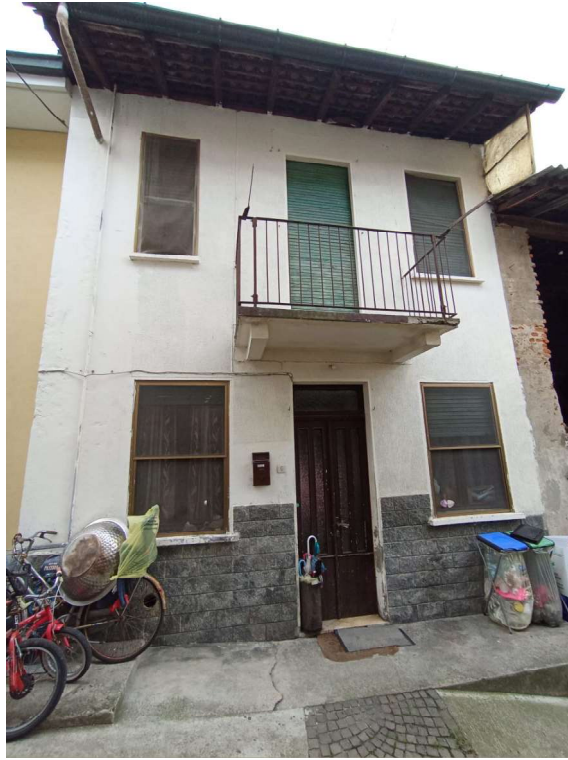
1 - Vista fronte ingresso
