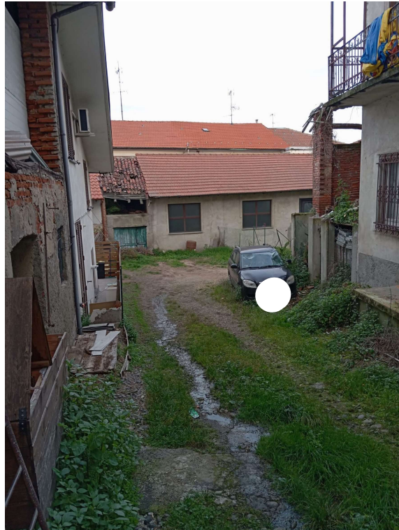
3 –Vista verso deposito sub. 59
