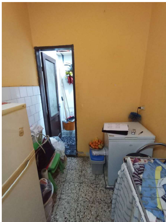
7. Piano terreno -Vista ripostiglio
