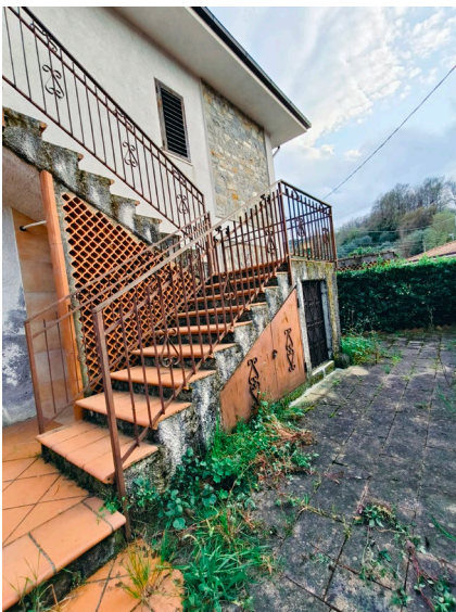
Figura 9: vista scala accesso/corte
