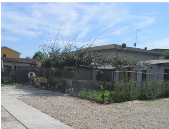
lato nord - est – locale sgombero
