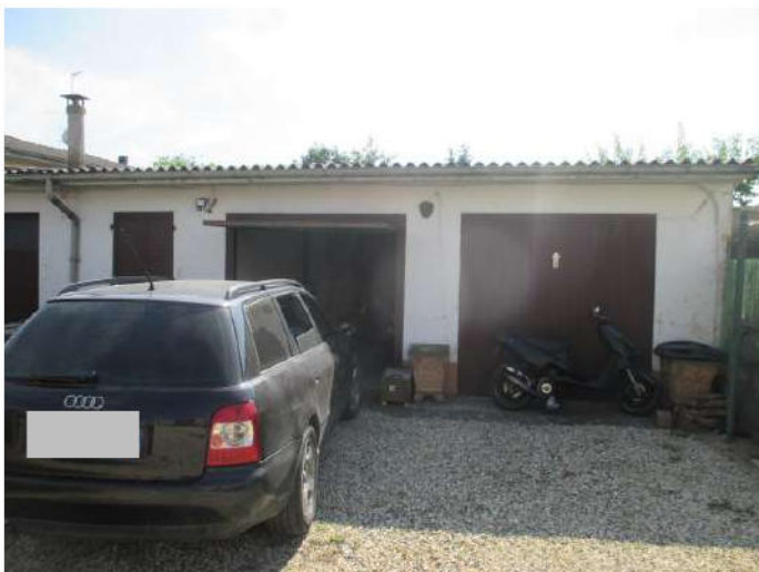
lato est – box
