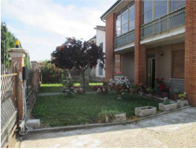
lato est - giardino
