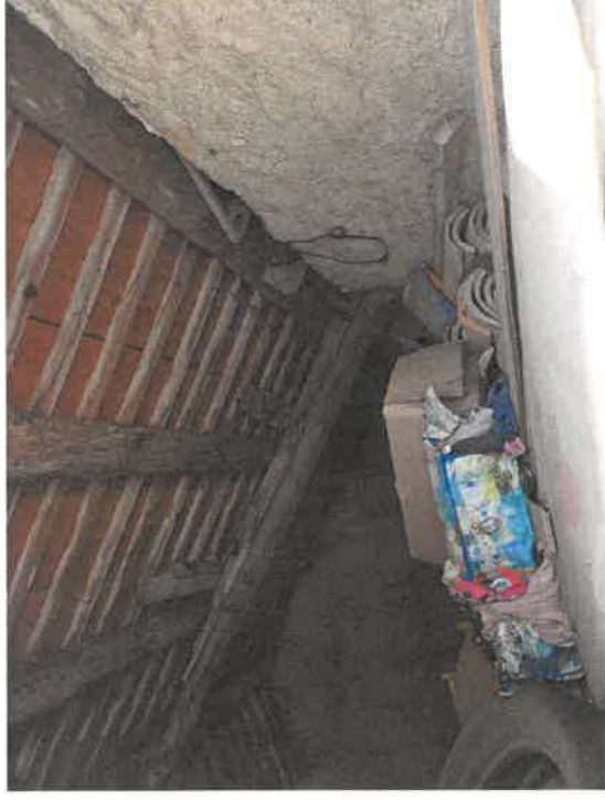
Foto n. 7 : C.F. Fg. 45 mapp. 368 e 369 - Soffitta
