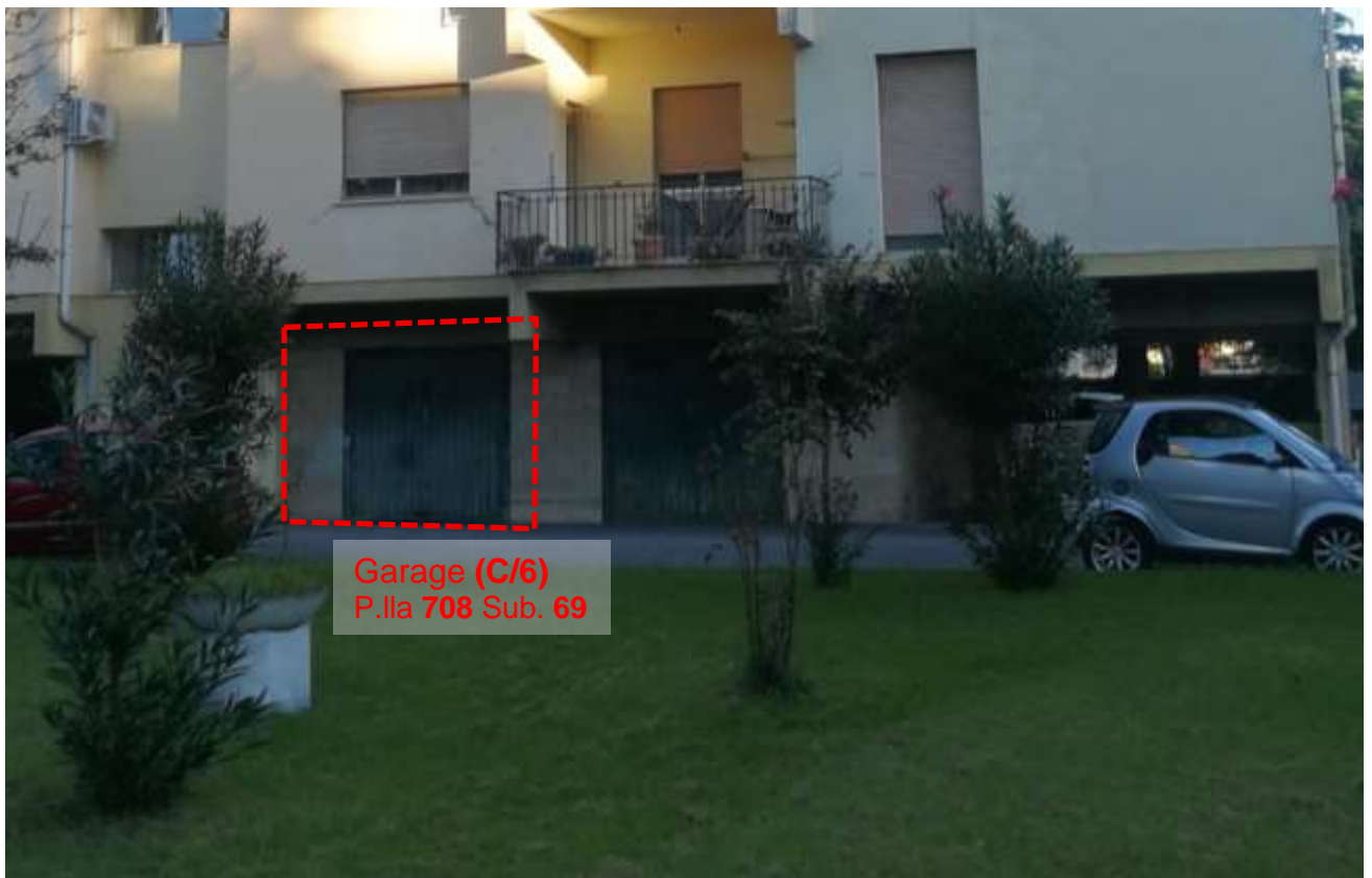
FOTO 08 (garage con accesso dalla corte condominiale)
