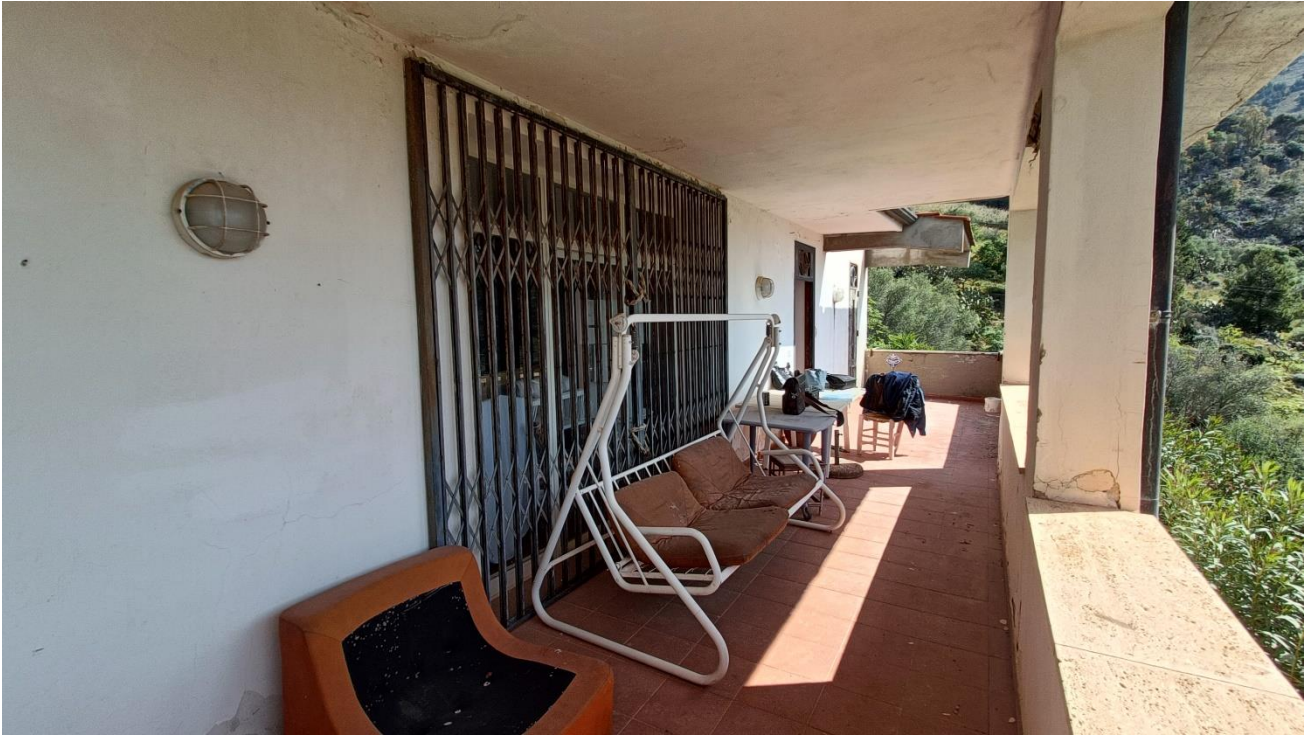
Foto 23 – Terrazzo con vista la portafinestra del soggiorno
