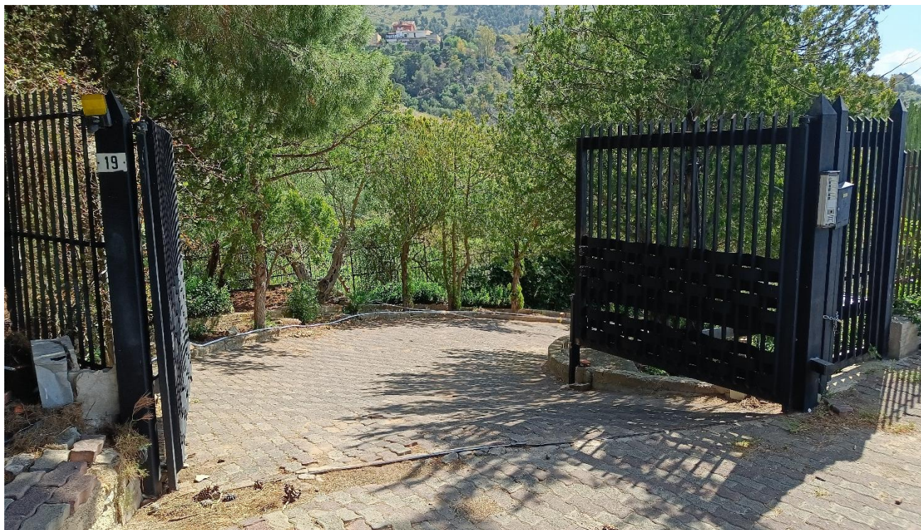
Foto 1 – Accesso all'area pertinenziale dell'edificio
