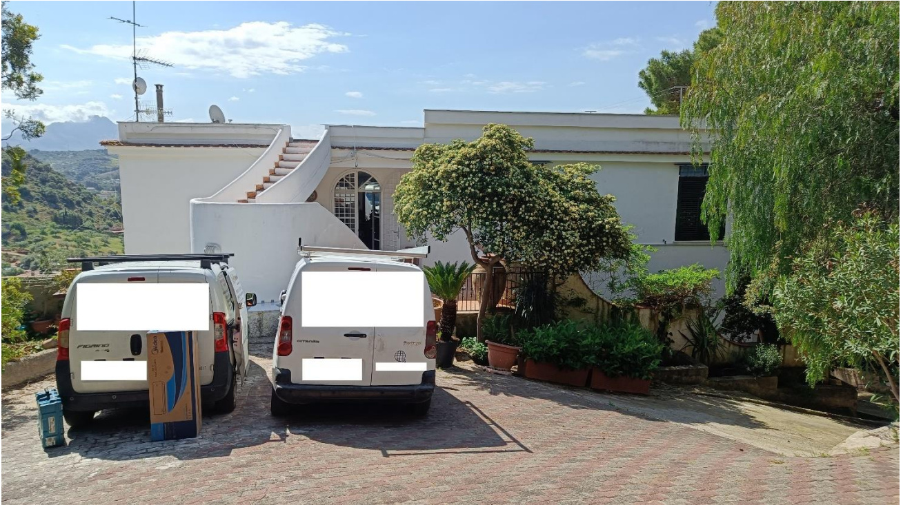
Foto 3 – Prospetto posteriore dell'edificio
