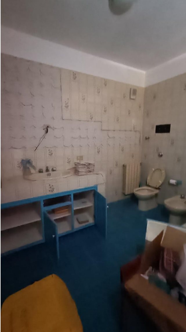
Foto 17 – Bagno con vista interna
