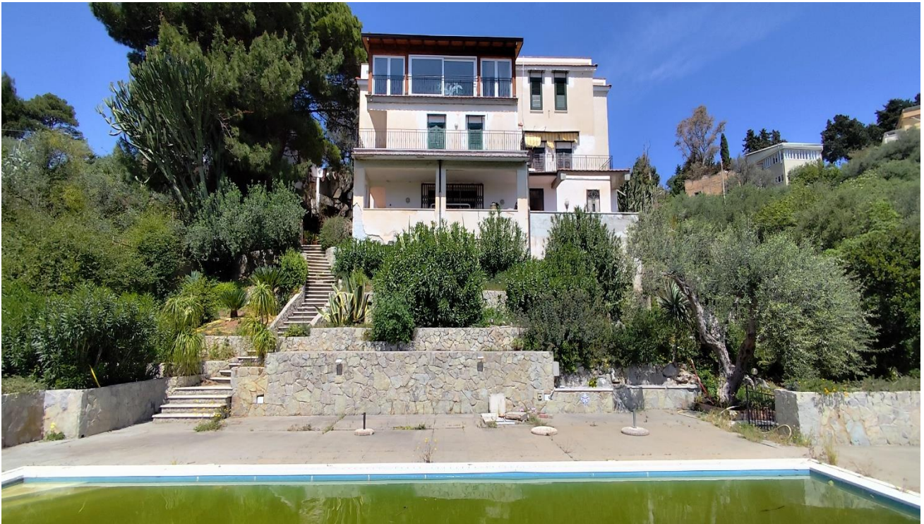
Foto 25 – Prospetto posteriore visto dalla piscina
