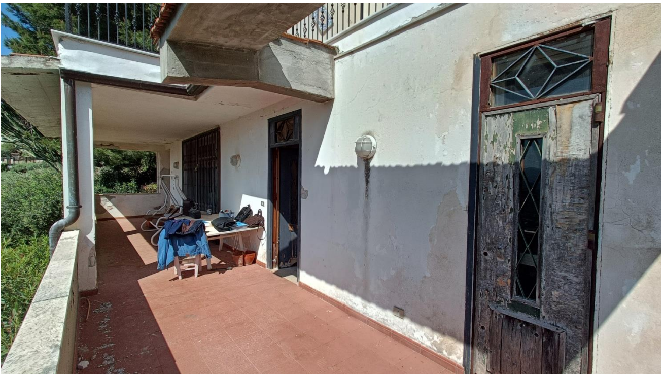
Foto 24 – Terrazzo con vista la porta d'ingresso e la portafinestra della cucina
