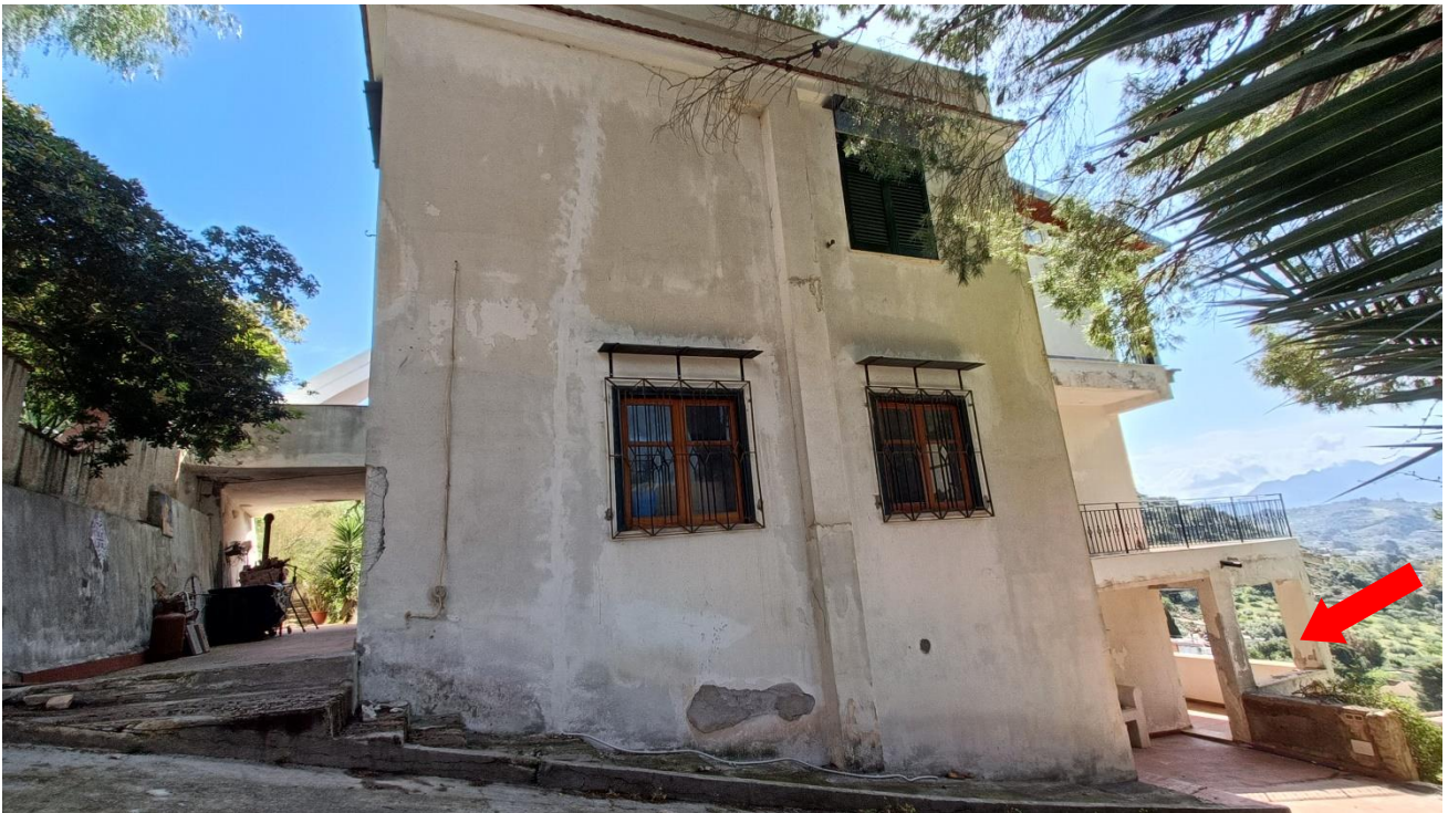
Foto 4 – Prospetto laterale dell'edificio
