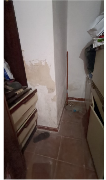
Ripostiglio 7 – Umidità/Infiltrazione
