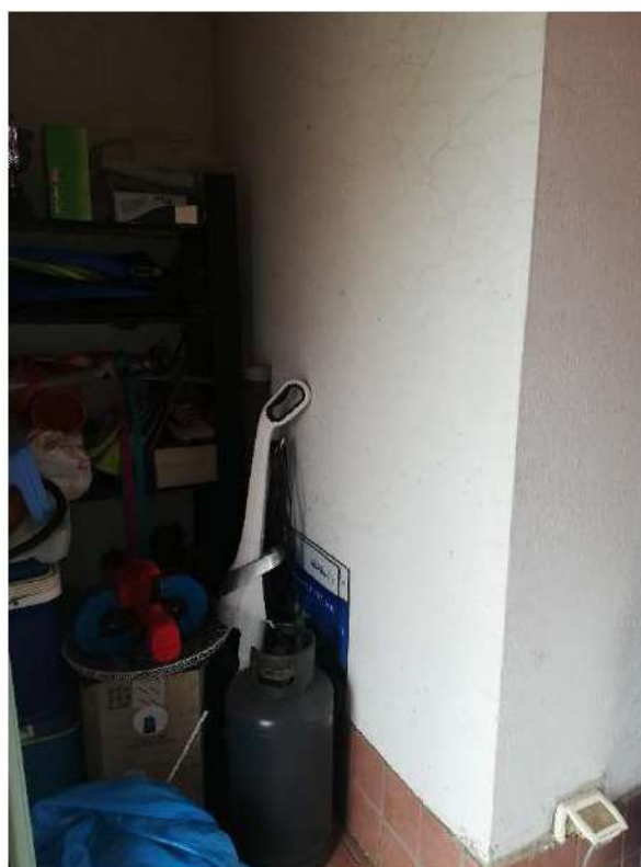
Rilievo Interno P1: Foto 25
