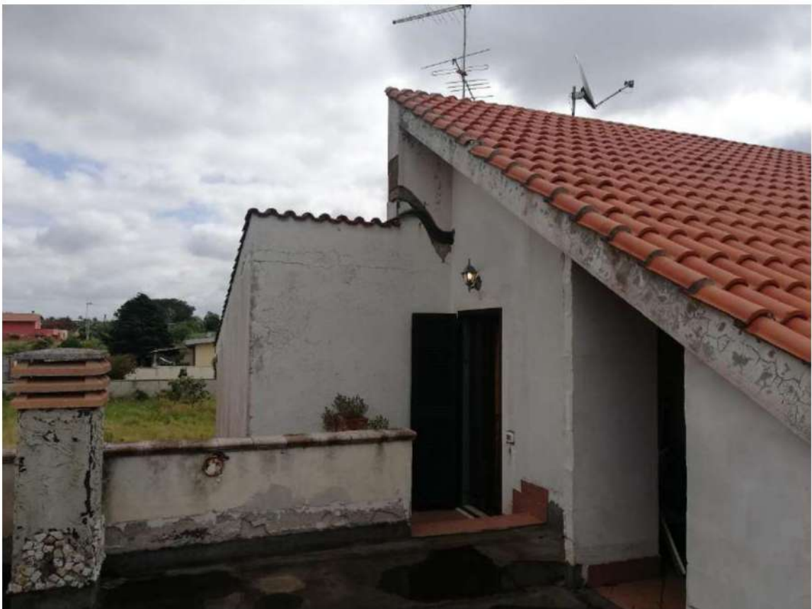
Rilievo Interno P1: Foto 27
