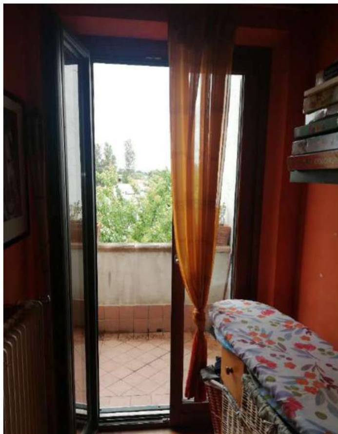
Rilievo Interno P1: Foto 20
