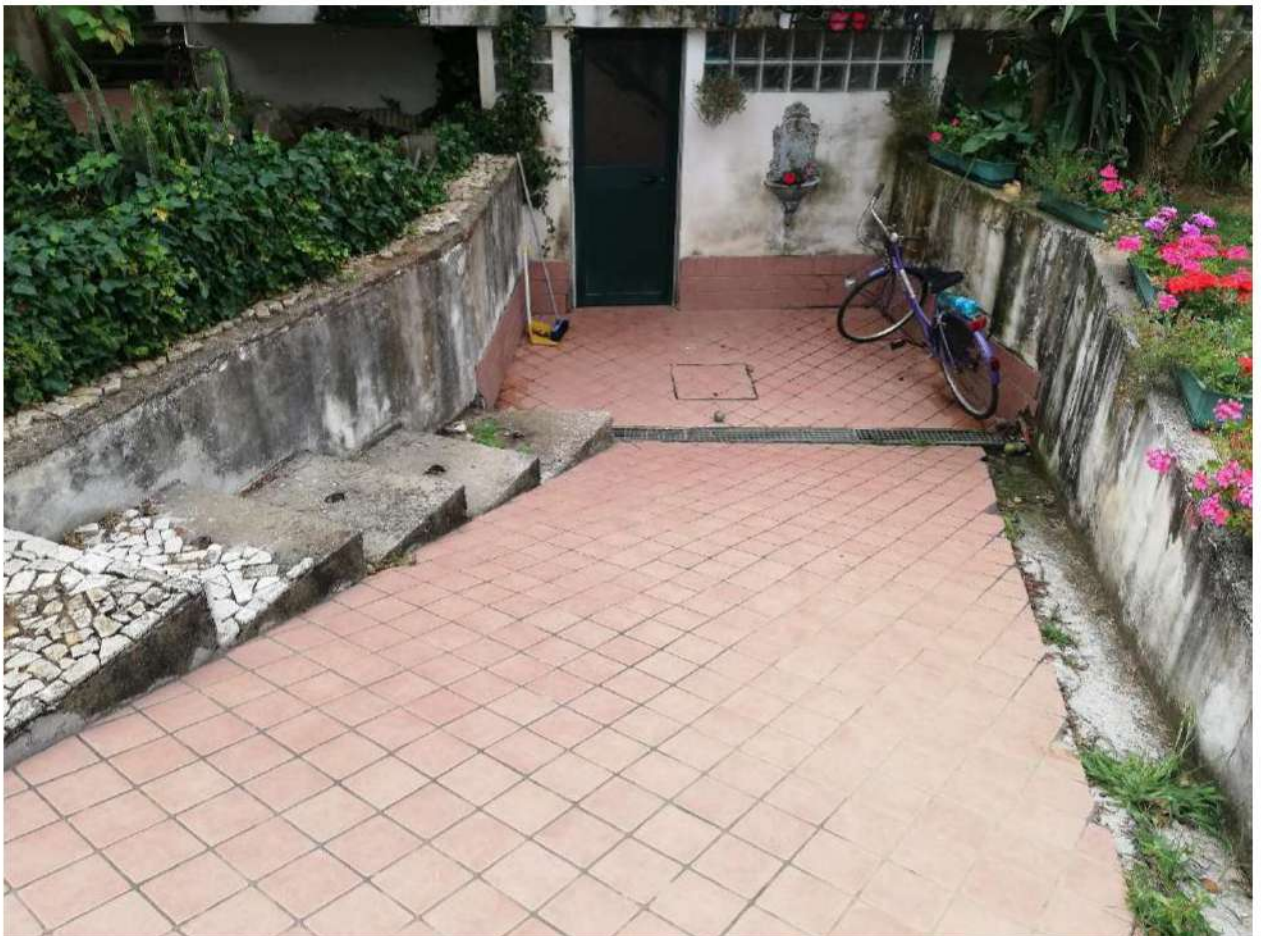
Rilievo Corte: Vista 6-Ingresso all'intercapedineche al momento del sopralluogo risultava adibito a magazzino
