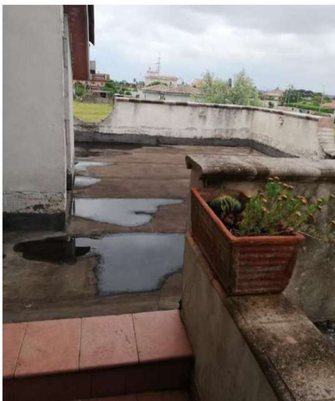
Rilievo Interno P1: Foto 21
