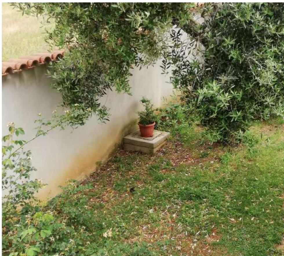
Rilievo Corte: Vista 4-Pozzetto corrispondente a canale tombato in prossimità muro di recinzione su confine Sud-Ovest.
