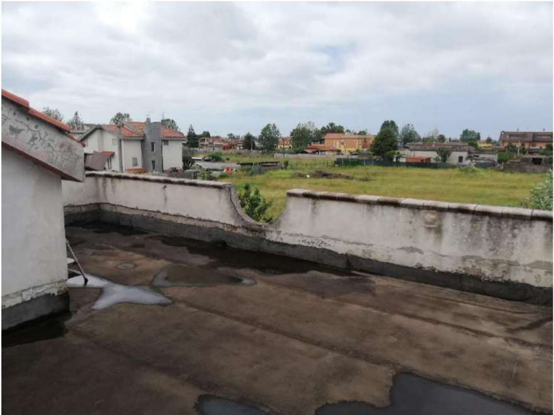
Rilievo Interno P1: Foto 22
