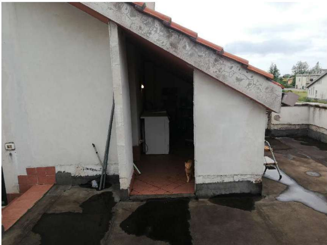
Rilievo Interno P1: Foto 23
