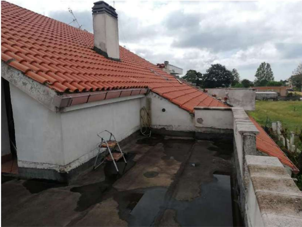
Rilievo Interno P1: Foto 26
