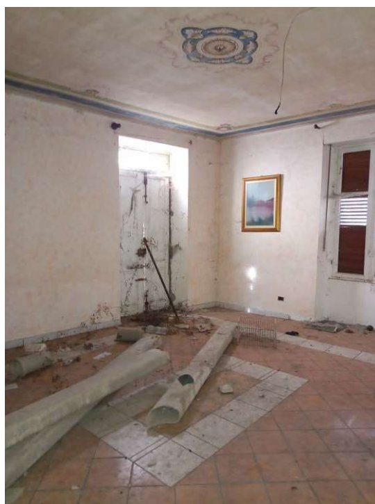
Vista interna locale Soggiorno
