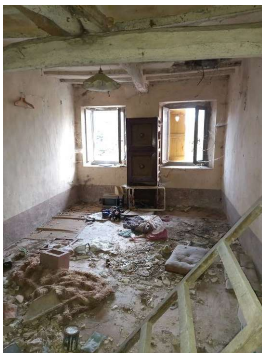
Vista interna locale Ripostiglio 4
