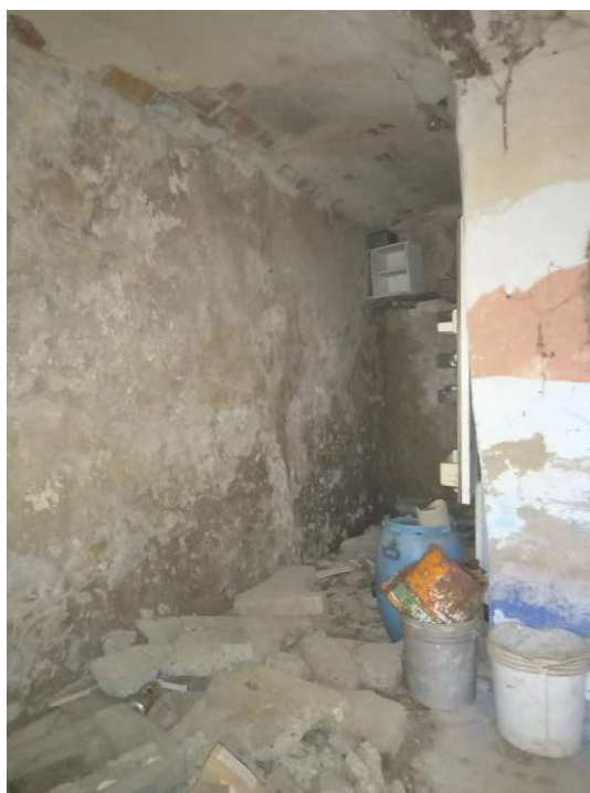
Vista interna locale Ripostiglio 1-2
