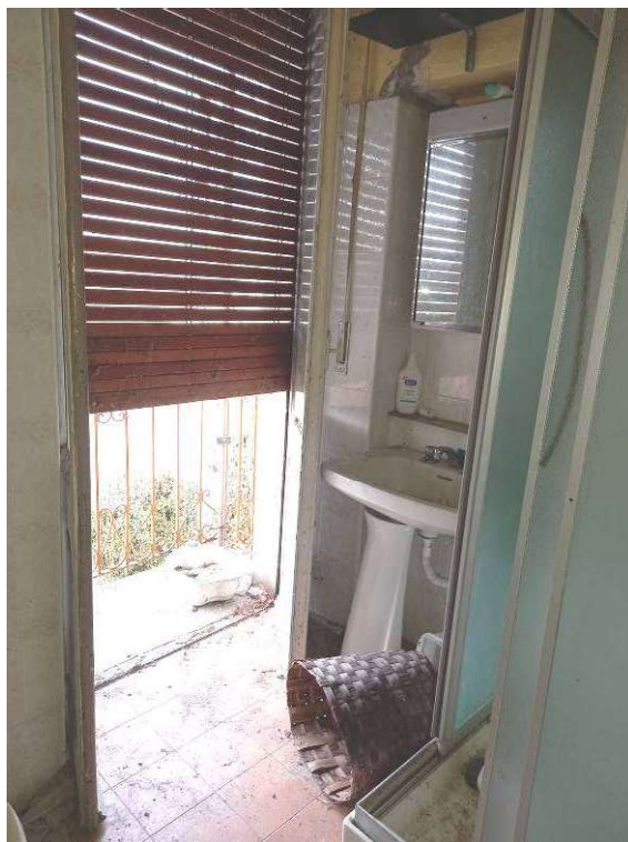
Vista interna locale Bagno
