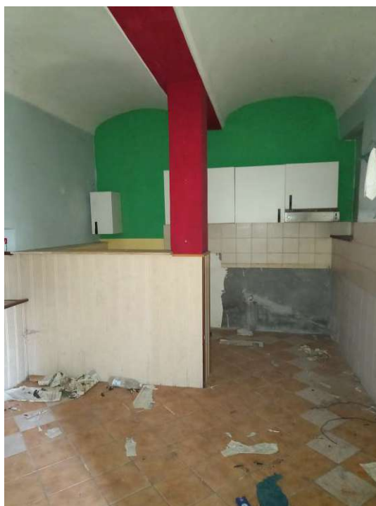
Vista interna locale Cucina
