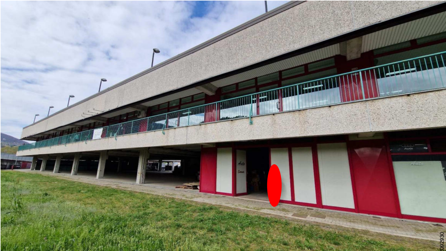
Accesso immobile da area esterna
