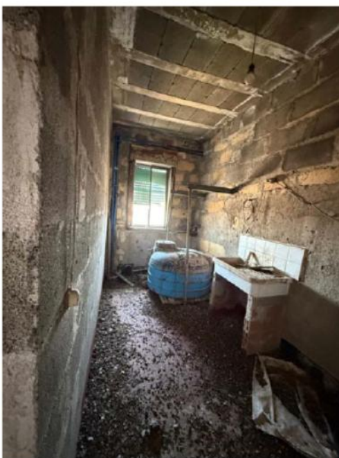
Wc al terzo piano
