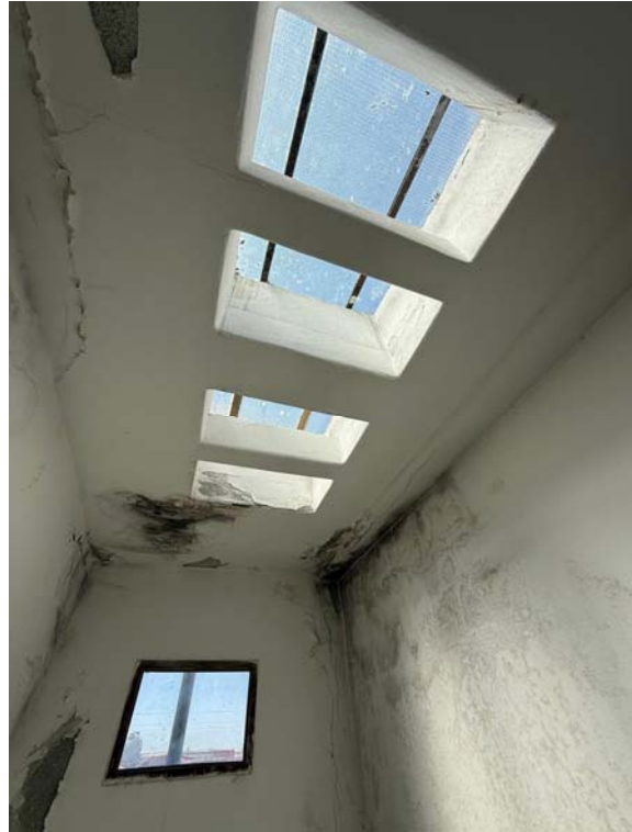
Vano scala interno
