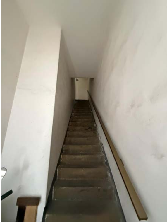
Vano scala interno
