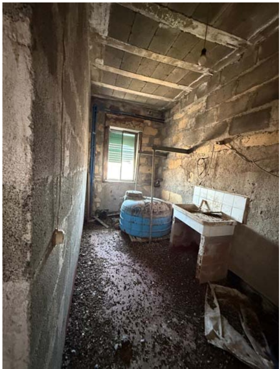
Wc al terzo piano
