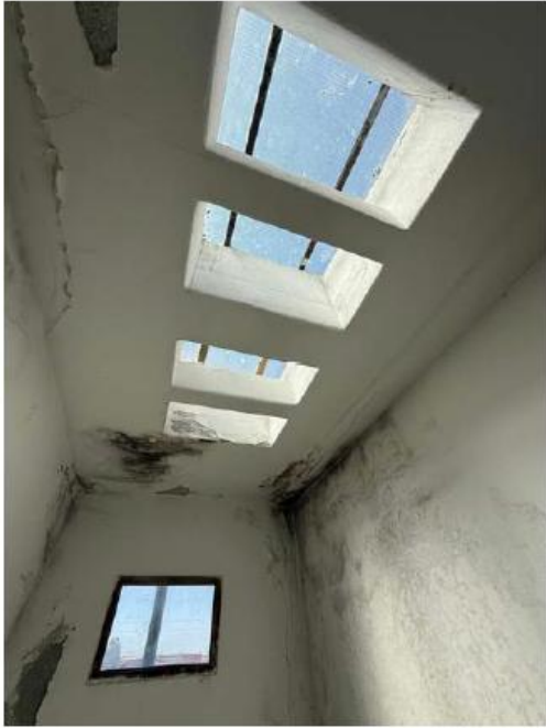
Vano scala interno
