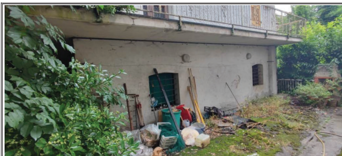
Foto n. 5 – Vista del fabbricato - Facciata lato OVEST
