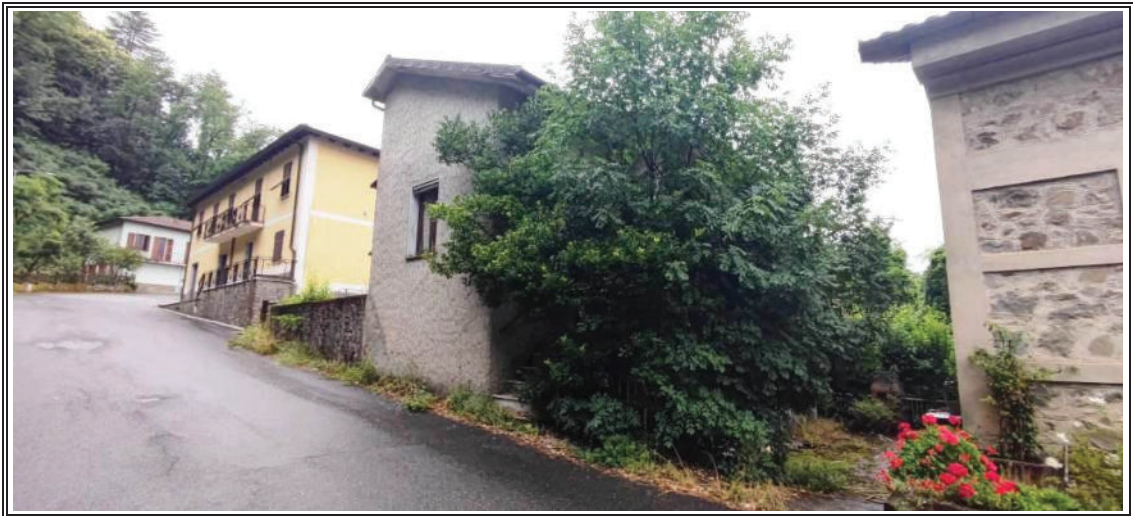
Foto n. 1 – Vista del fabbricato angolo NORD/OVEST
