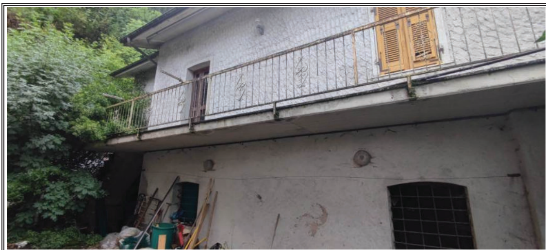
Foto n. 4 – Vista del fabbricato - Facciata lato OVEST
