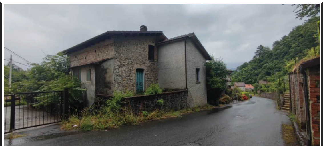
Foto n. 3 – Vista del fabbricato angolo NORD/EST
