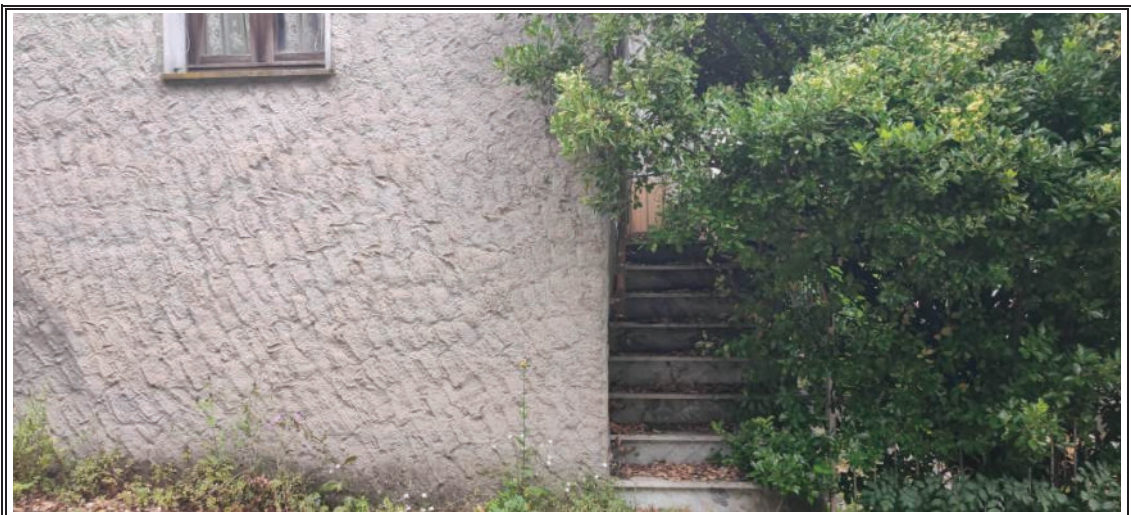
Foto n. 2 – Vista del fabbricato – Scale di ingresso al piano primo
