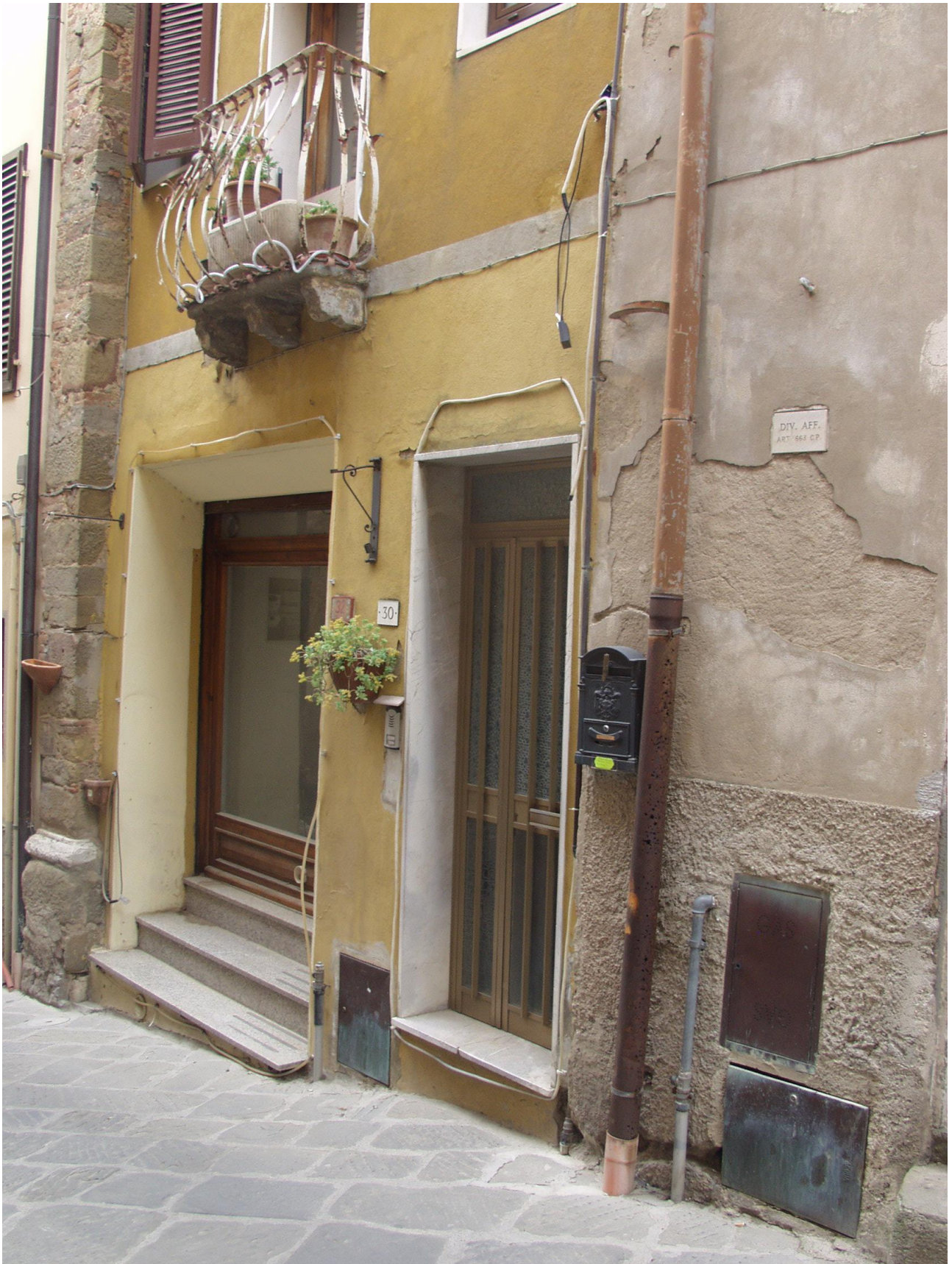
Punto di vista generale – Accesso dalla Via G.Citerni
