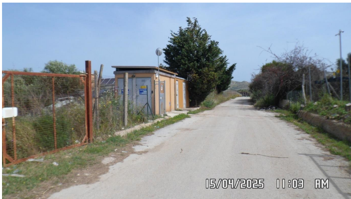
Foto 1 – Veduta della cabina elettrica da Sud
