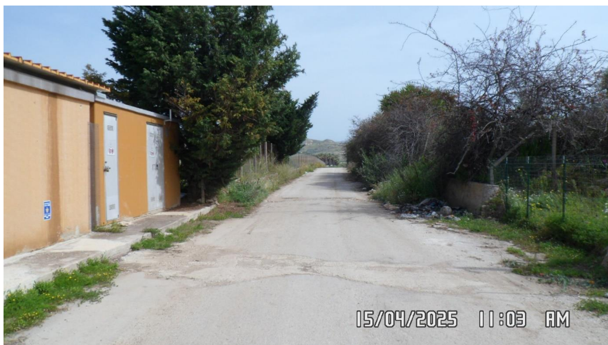
Foto 2 – Veduta del lato est della cabina elettrica
