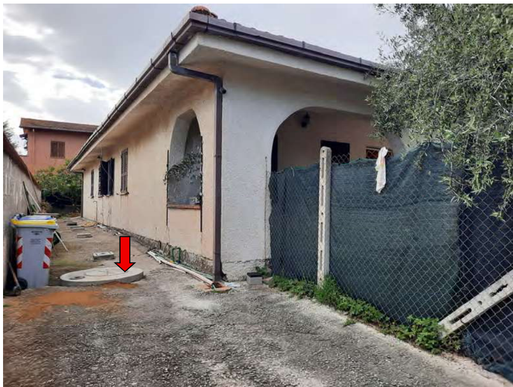
FOTO 1 – VISTA DAL CANCELLO DI ACCESSO CON FOSSA IMHOFF
