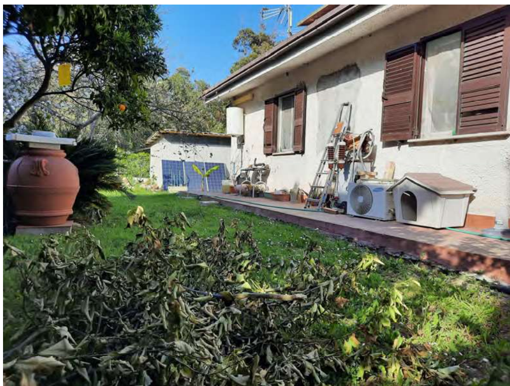
FOTO 3 – VISTA DAL LATO OVEST
