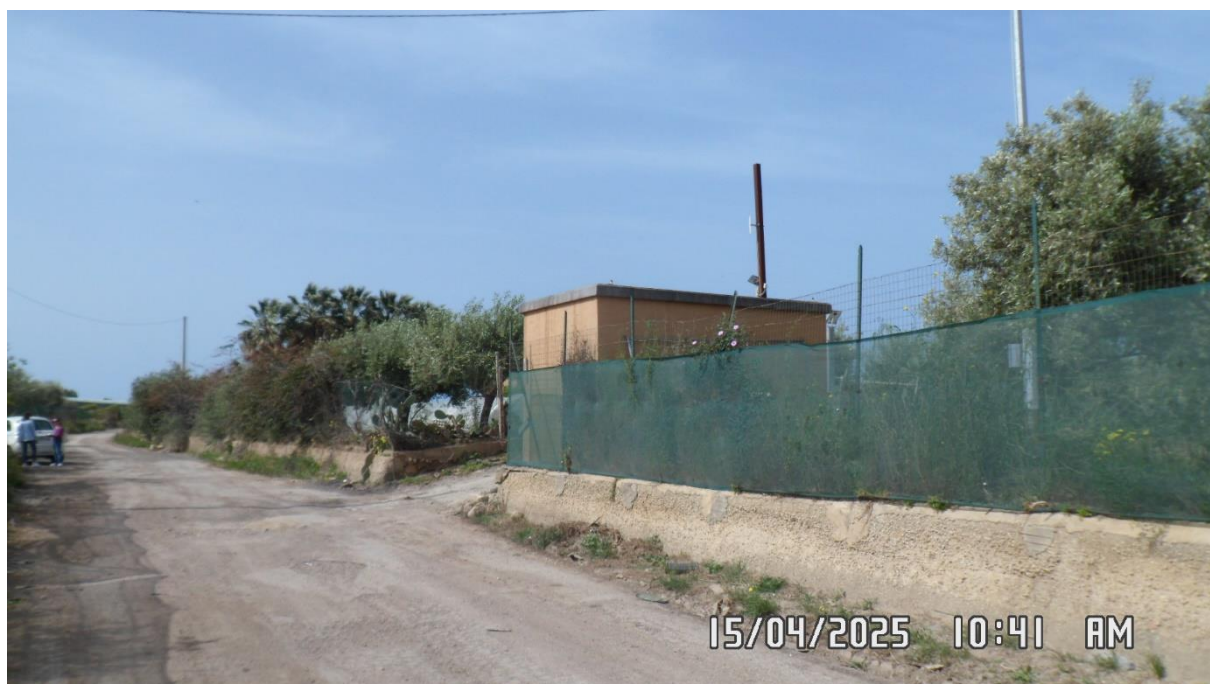
Foto 6 – Veduta della cabina elettrica da Nord
