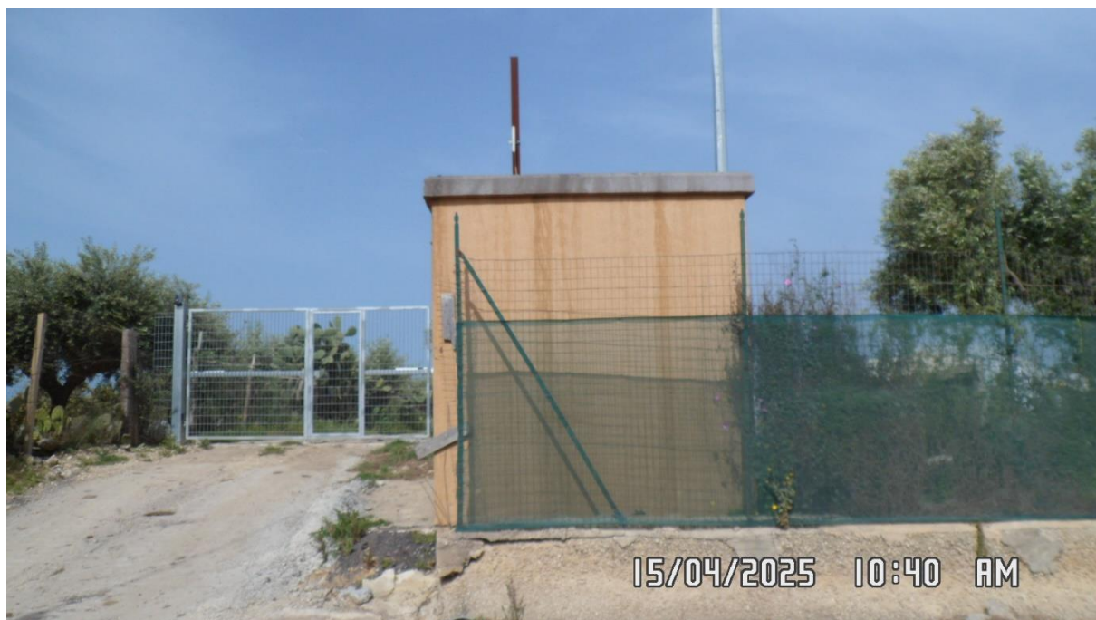
Foto 1 – Veduta della cabina elettrica da Est
