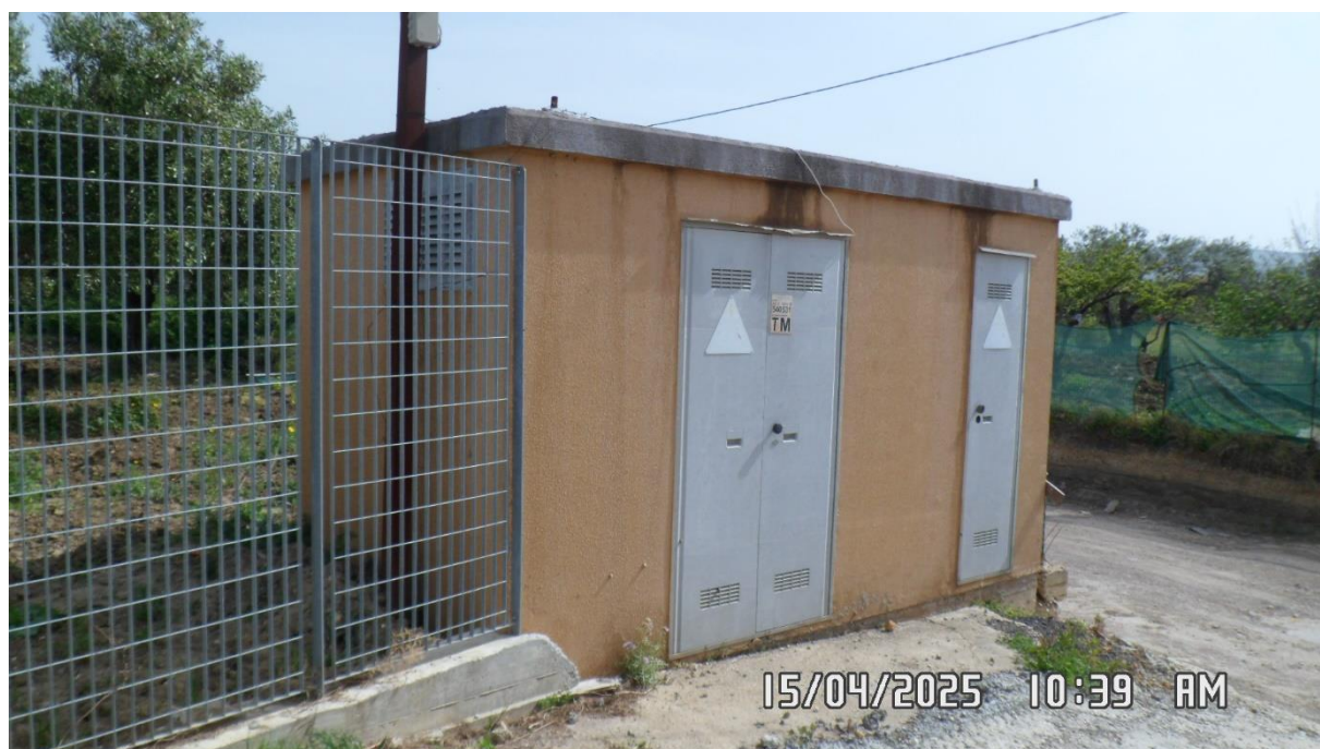
Foto 3 – Veduta della cabina elettrica dalla stradella
