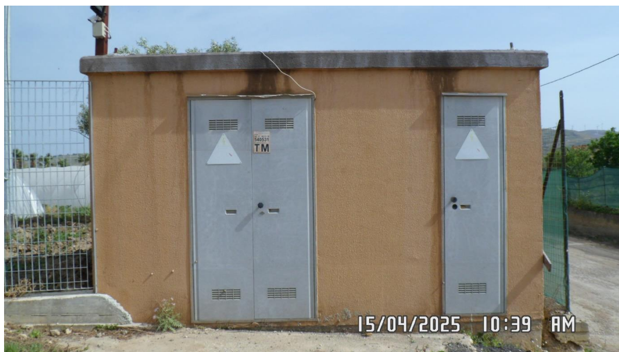
Foto 4 – Veduta della cabina elettrica da sud
