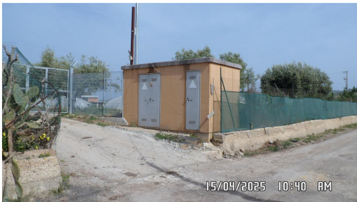
Foto 5 – Veduta della cabina elettrica da Sud Est
