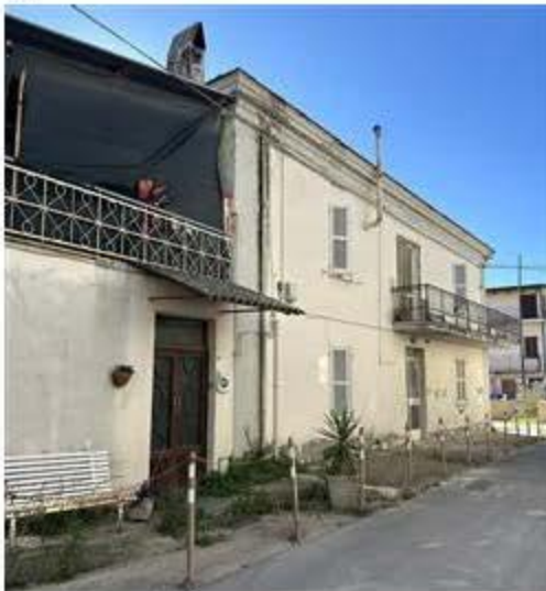
Ingresso piano terra
