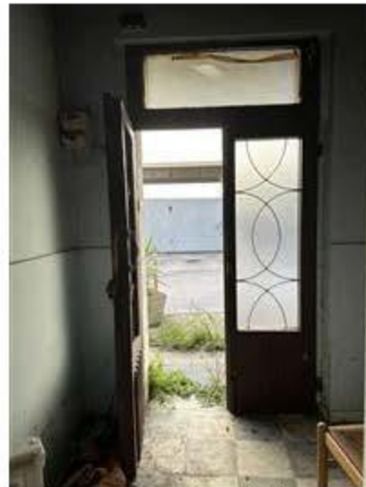
Portoncino ingresso visto dall'interno
