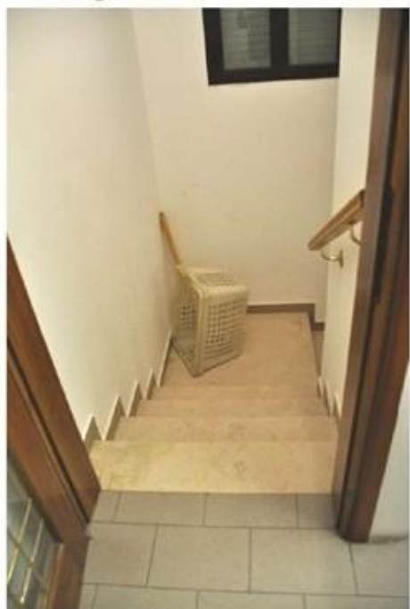
54 – Scala di accesso all'interrato
