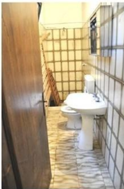
60 – Servizio igienico alla base della scala
