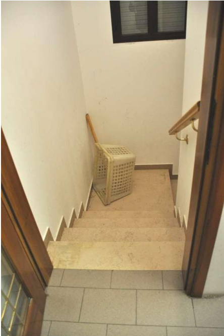
54 – Scala di accesso all'interrato
