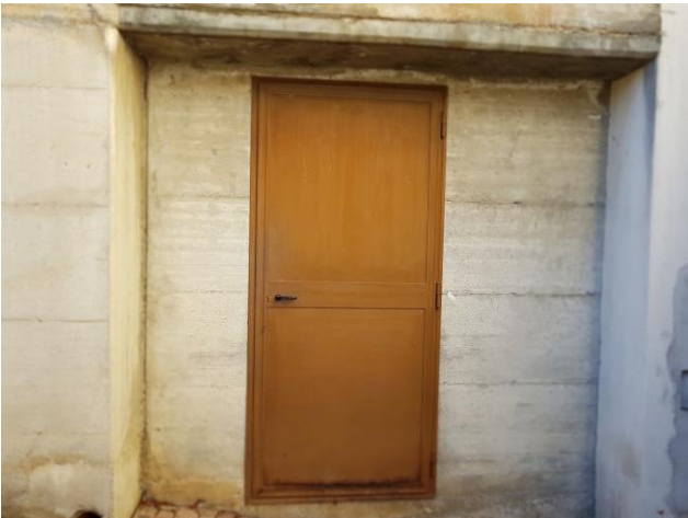
66 – Porta d'accesso al locale centrale termica
