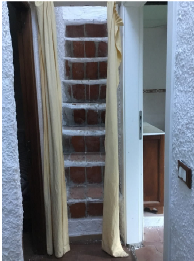
Foto n° 11 – Vista della scala di accesso al terzo livello
