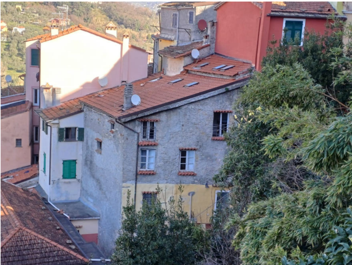
Foto n° 3 e 4 – Vista dei prospetti sud e est da Via Valentini
