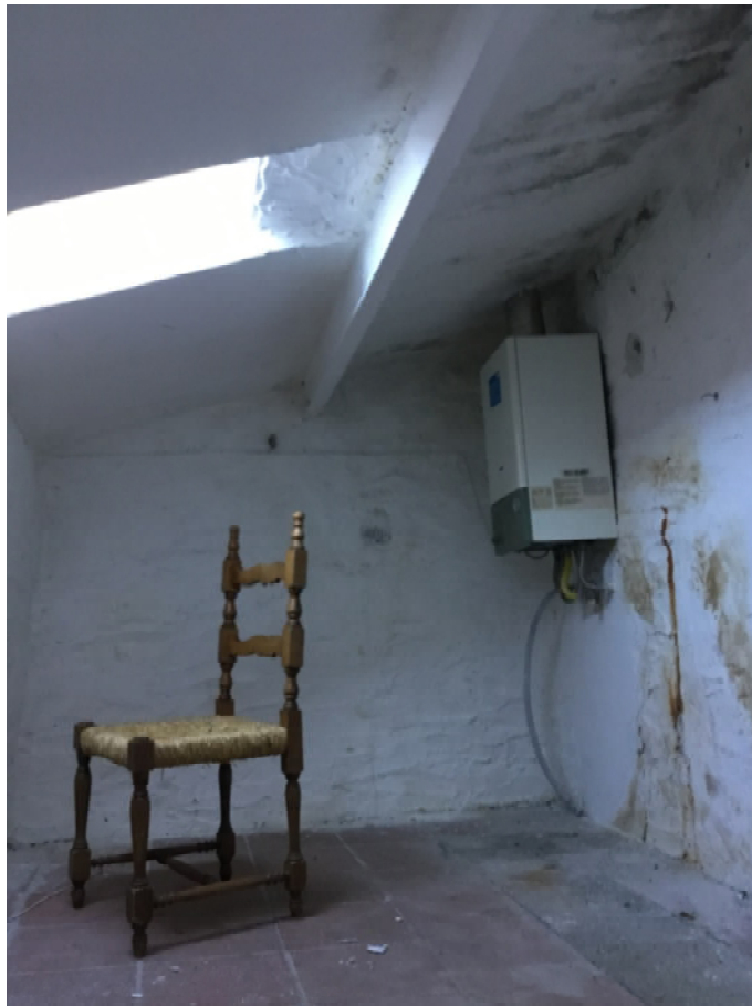
Foto n° 12 – Vista del vano posto al terzo livello
