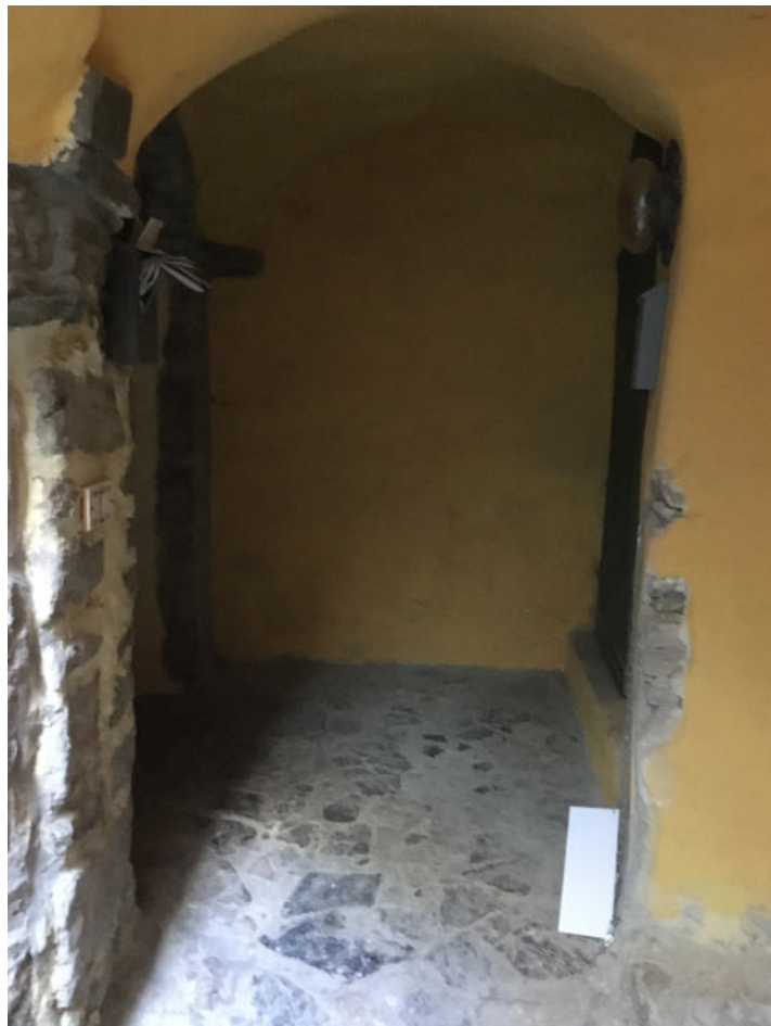
Foto n° 6 – Prospetto nord – particolare dell'accesso all'abitazione
