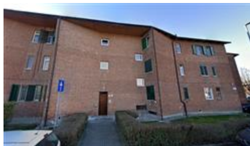
Facciata ingresso condominiale
