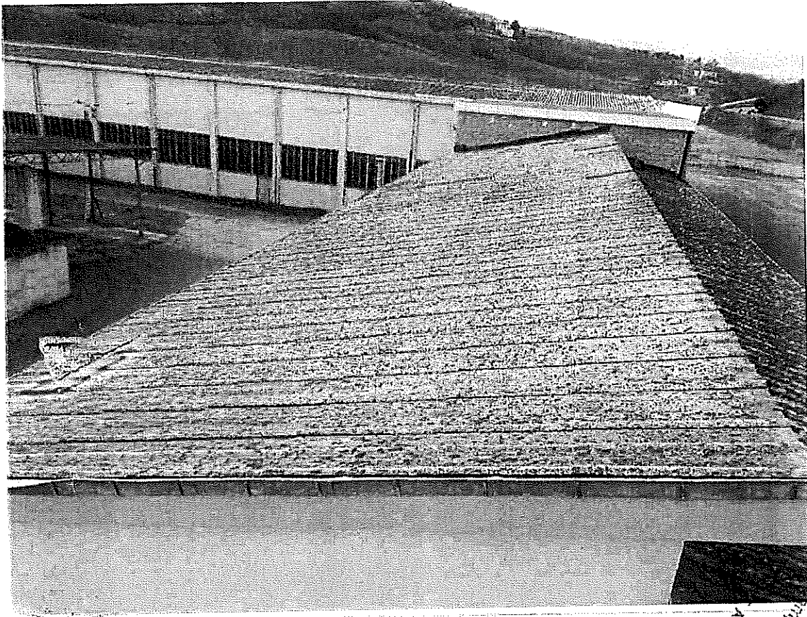
Particolari del discreto stato di conservazione delle lastre e dello sviluppo di licheni.
