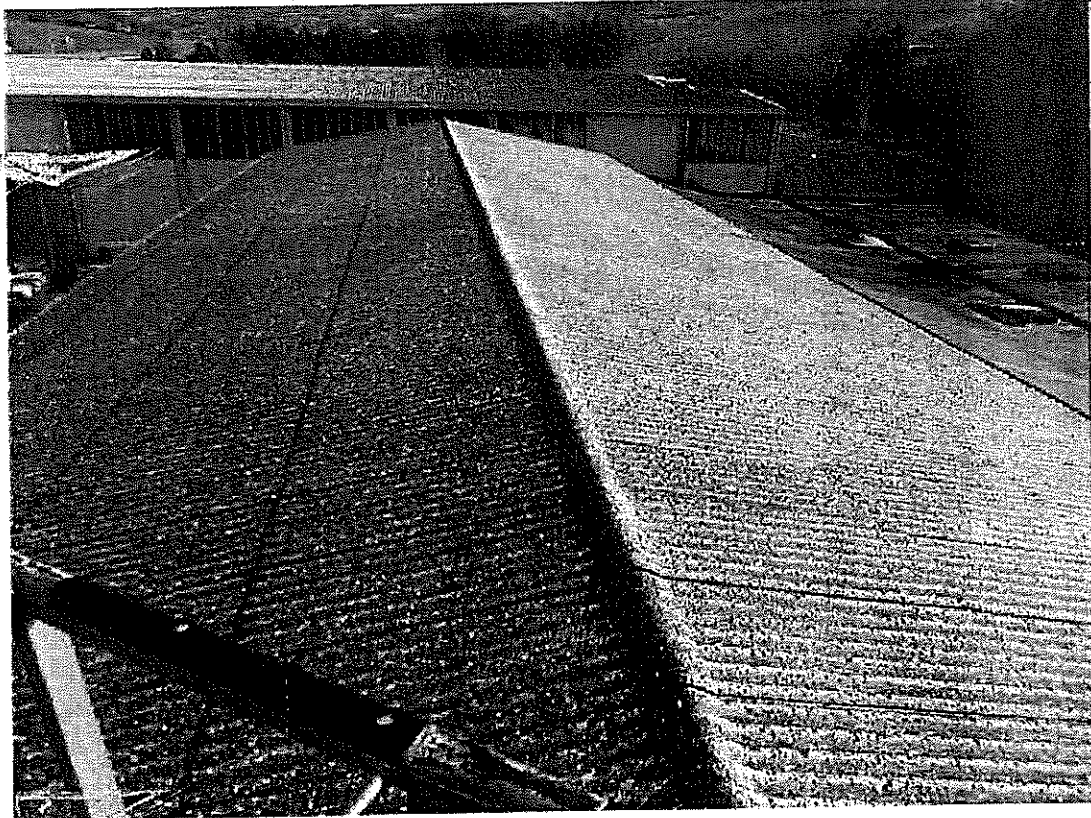
Particolari del discreto stato di conservazione delle lastre e della presenza di licheni
