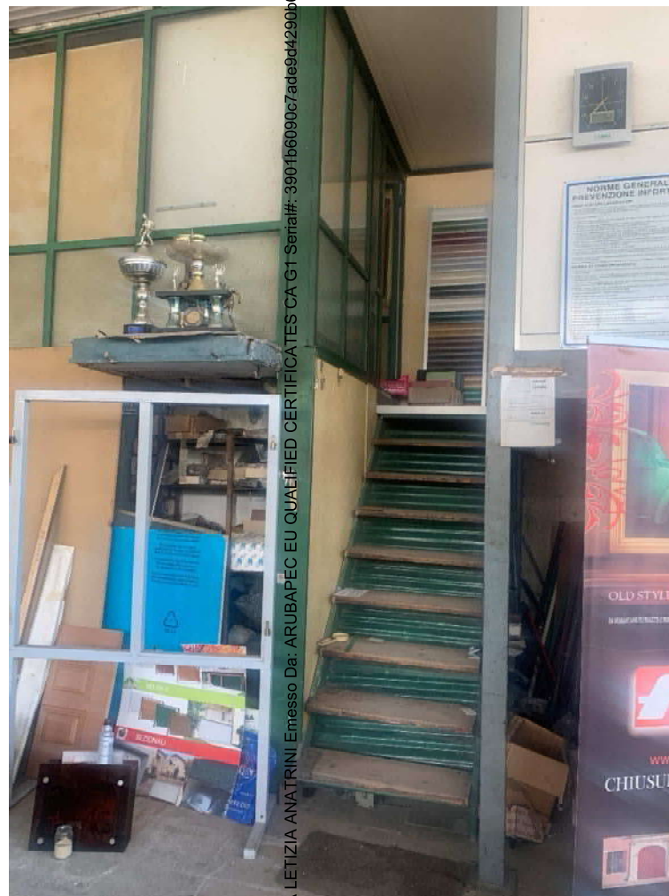
Vista accesso piano uffici
