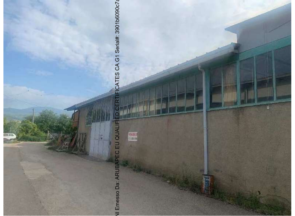
Vista laterale da strada condominiale
