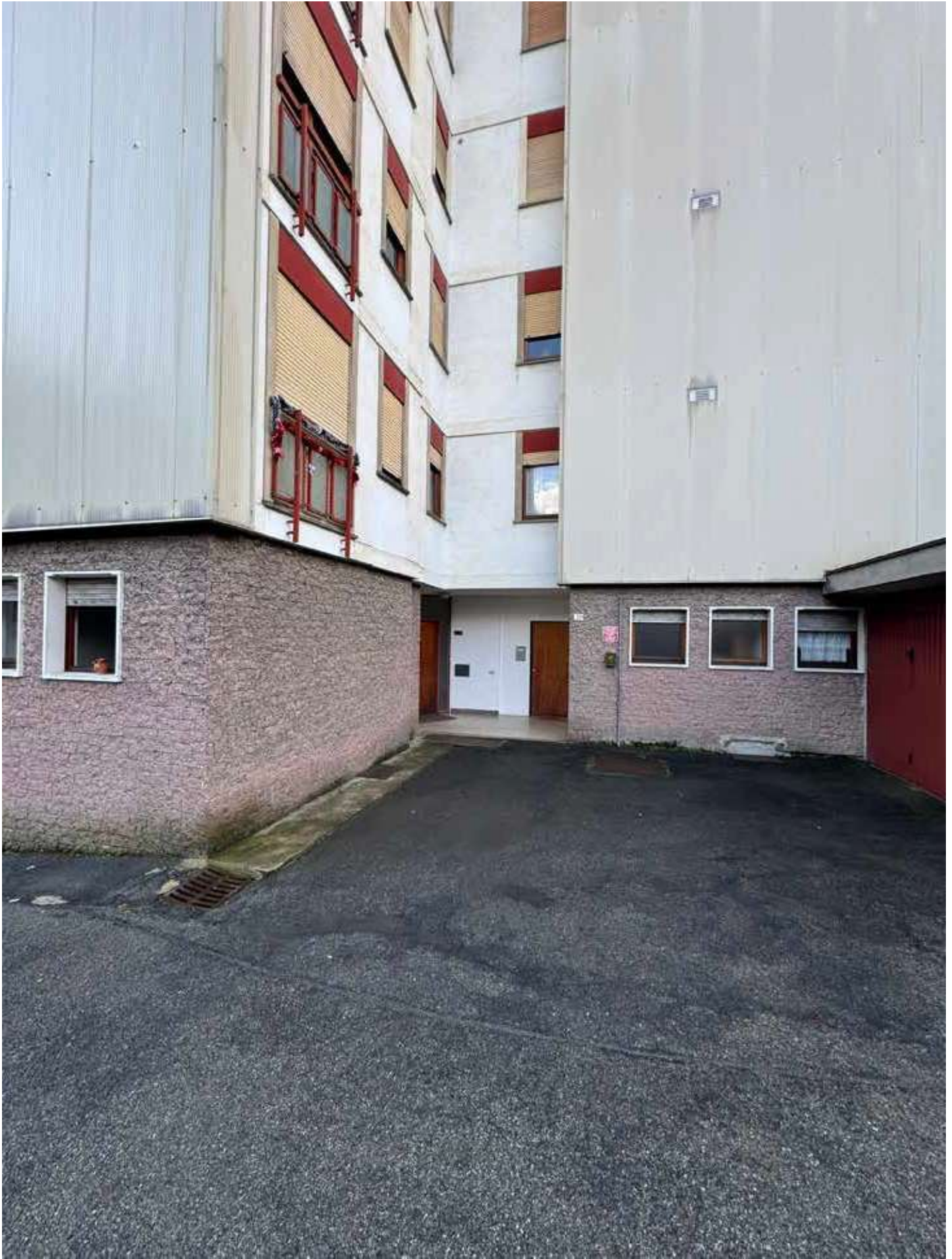
Ingresso da strada privata - Valduggia - (foto del 19.12.2025)
