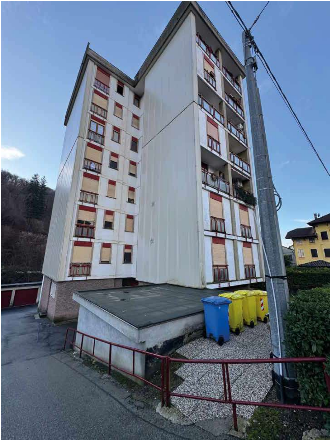
Fronte Nord su Via Cremosina - Valduggia - (foto del 19.12.2025)
