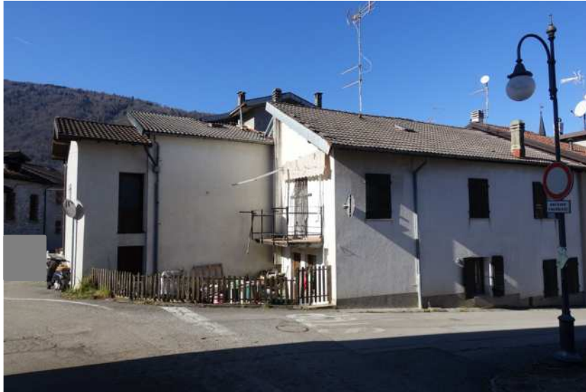
Vista fabbricato da est
