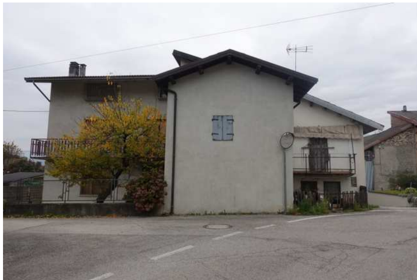
Vista fabbricato da nord
