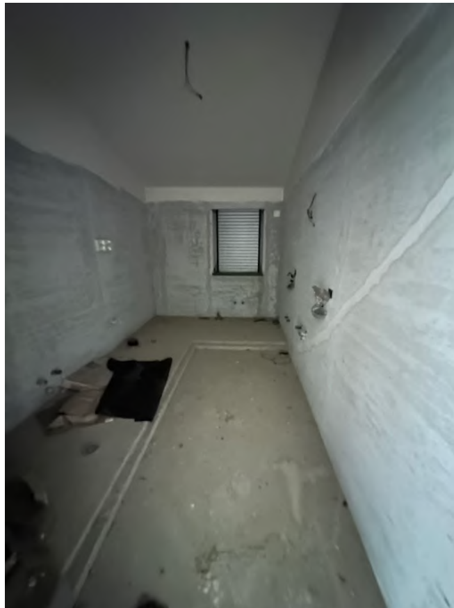
foto n.º12 – particolare bagno del P2
