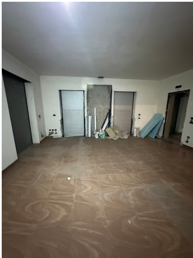
foto n.°8 – particolare soggiorno del P1
