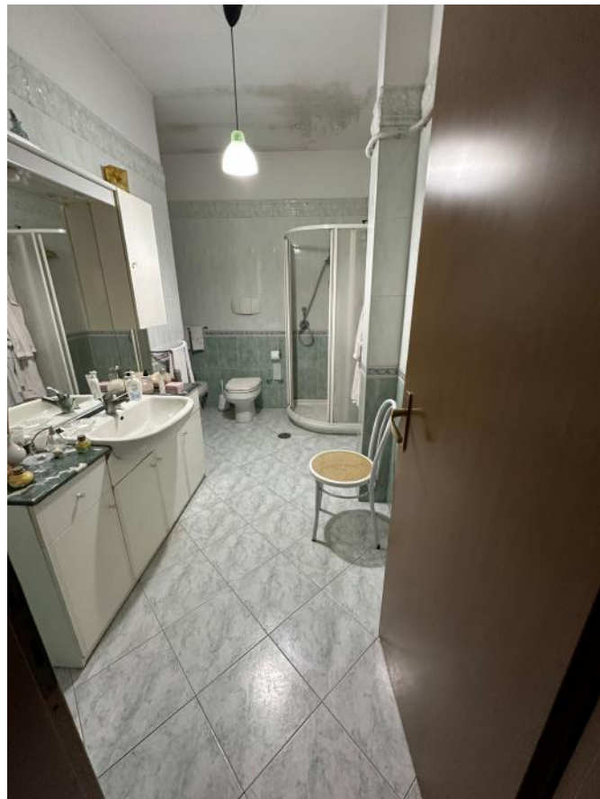
foto n.°6 – particolare bagno del PT/R
