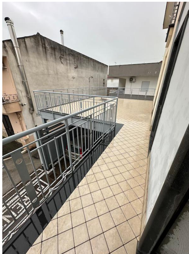
foto n.º10 – particolare terrazzo del P1
