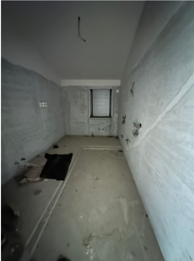
Foto n.9 – Particolare duplex sub 4
