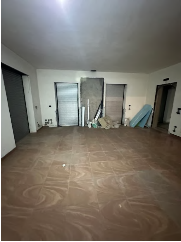
Foto n.7 – Particolare duplex sub 4
