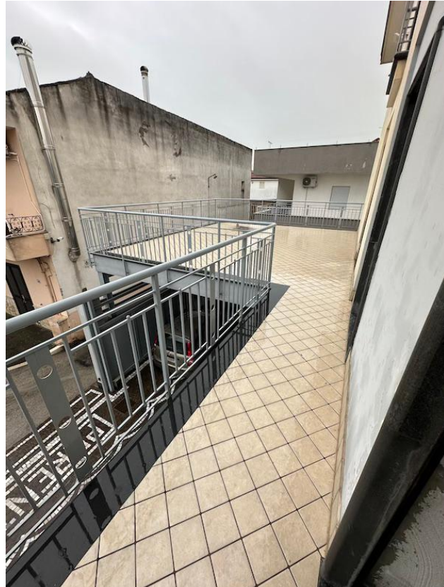
Foto n.10 – Particolare duplex sub 4
