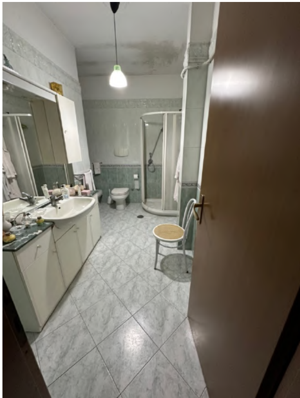
Foto n.5 – Particolare bagno sub 3
