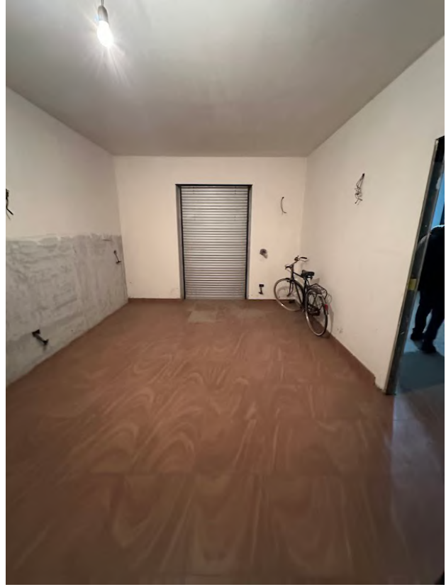
Foto n.8 – Particolare duplex sub 4
