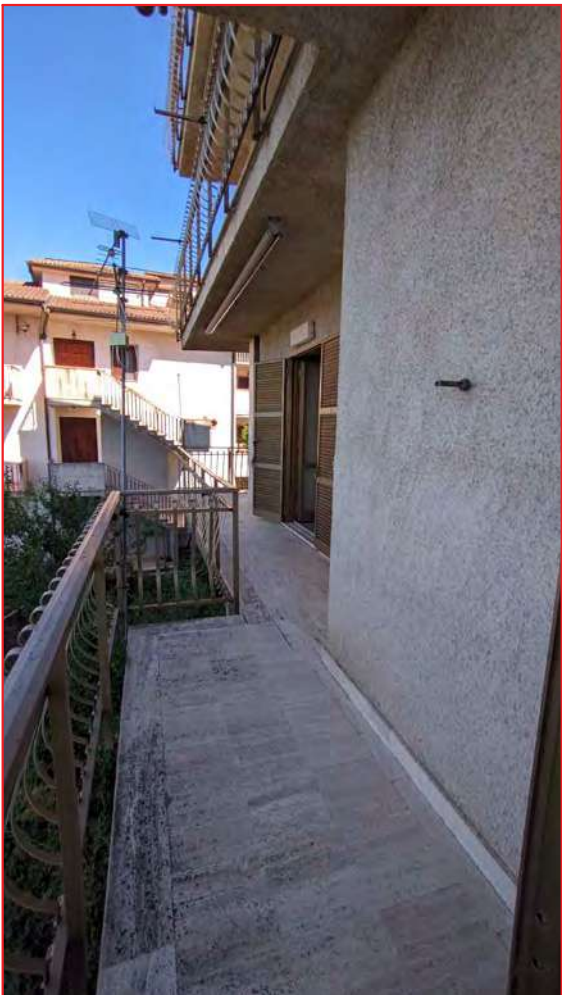
07 - Veduta del balcone verso valle
