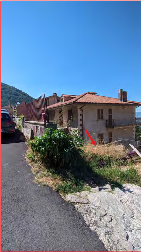
01 - Veduta da via D. Alighieri
