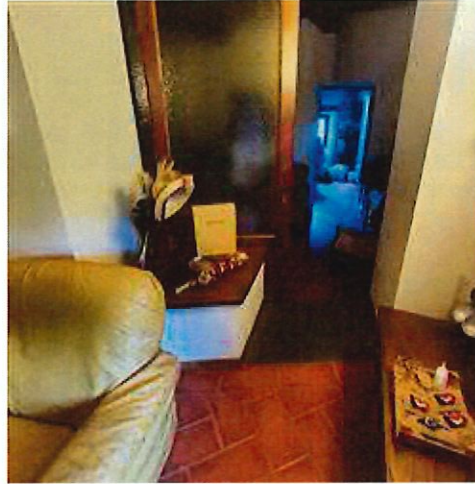
Piano primo vista porta tra soggiorno e camera. In evidenza piano di appoggio e sguanci non indicati o mal rappresentati
