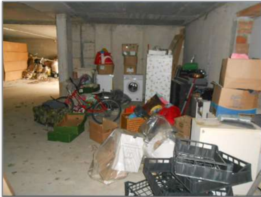
Foto 1 spazio dove dovrebbero esserci i magazzini/cantine
