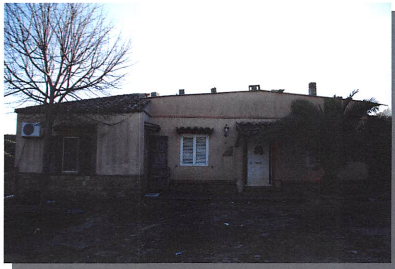
Foto del prospetto nord con le aperture
