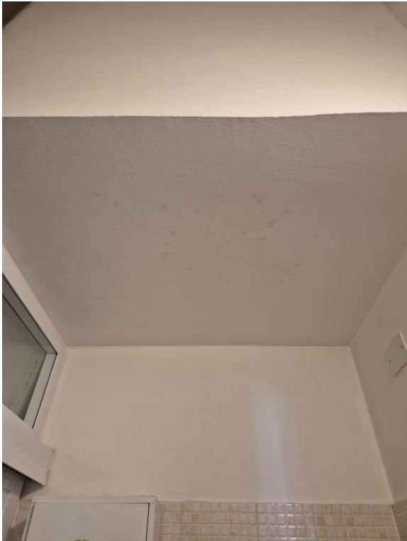
Segni di infiltrazioni soffitto bagno
