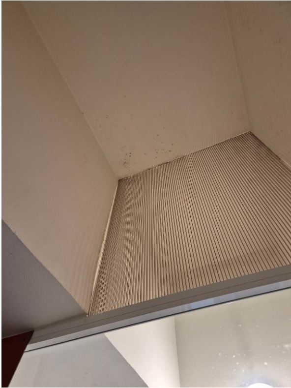
Segni infiltrazioni locale vendita: coontrosoffitto e muri perimetrali
