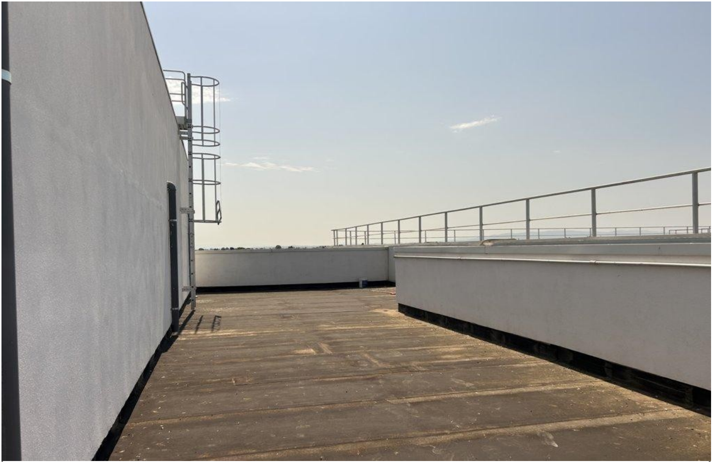
Esterno p.IIa 152 sub.16
