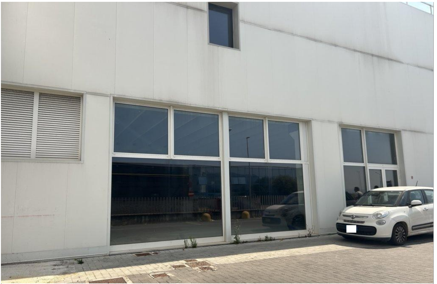
esterno p.IIa 152 sub.9
