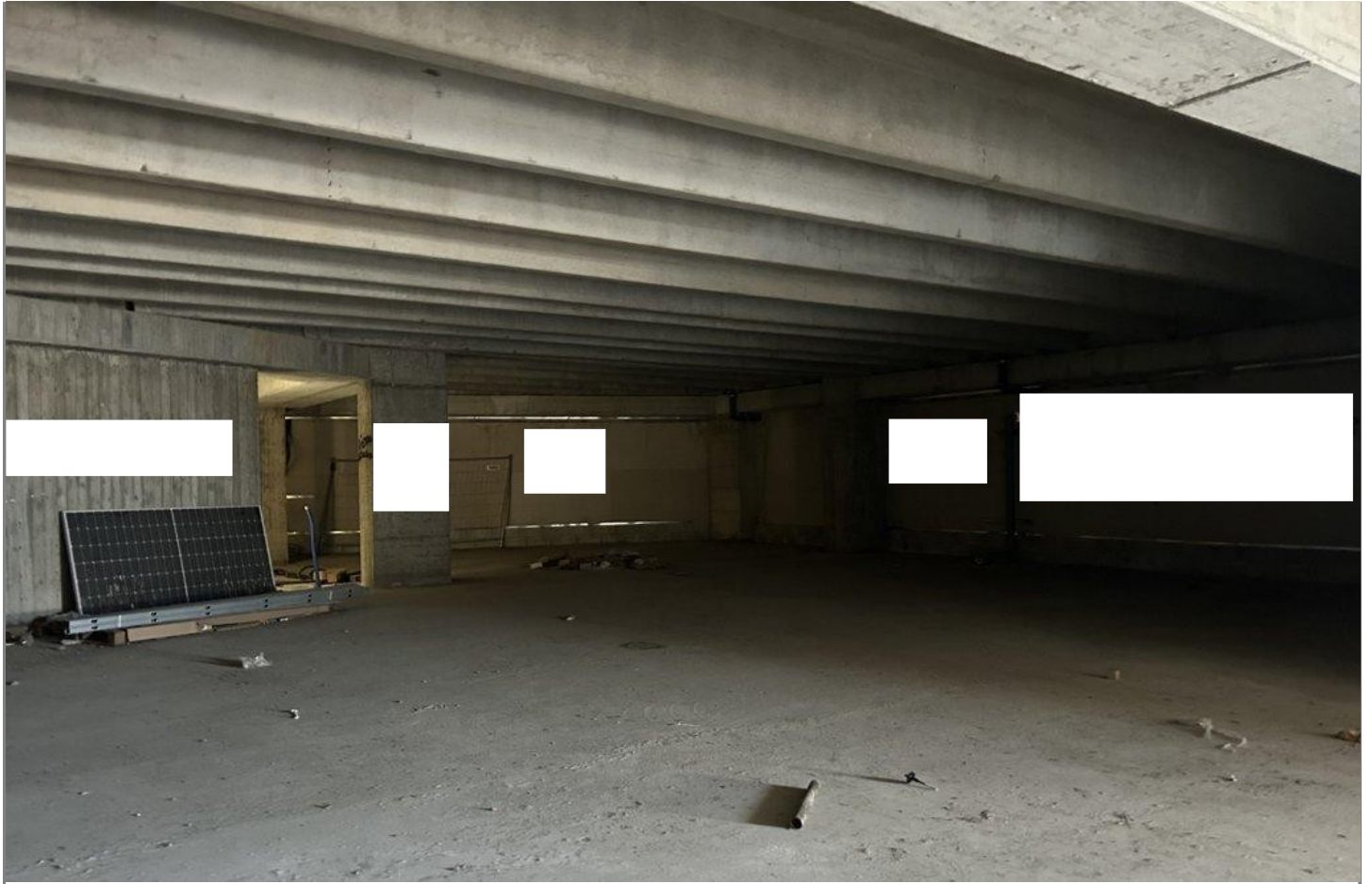
Interno p.lla 1359 sub.8 e 9
