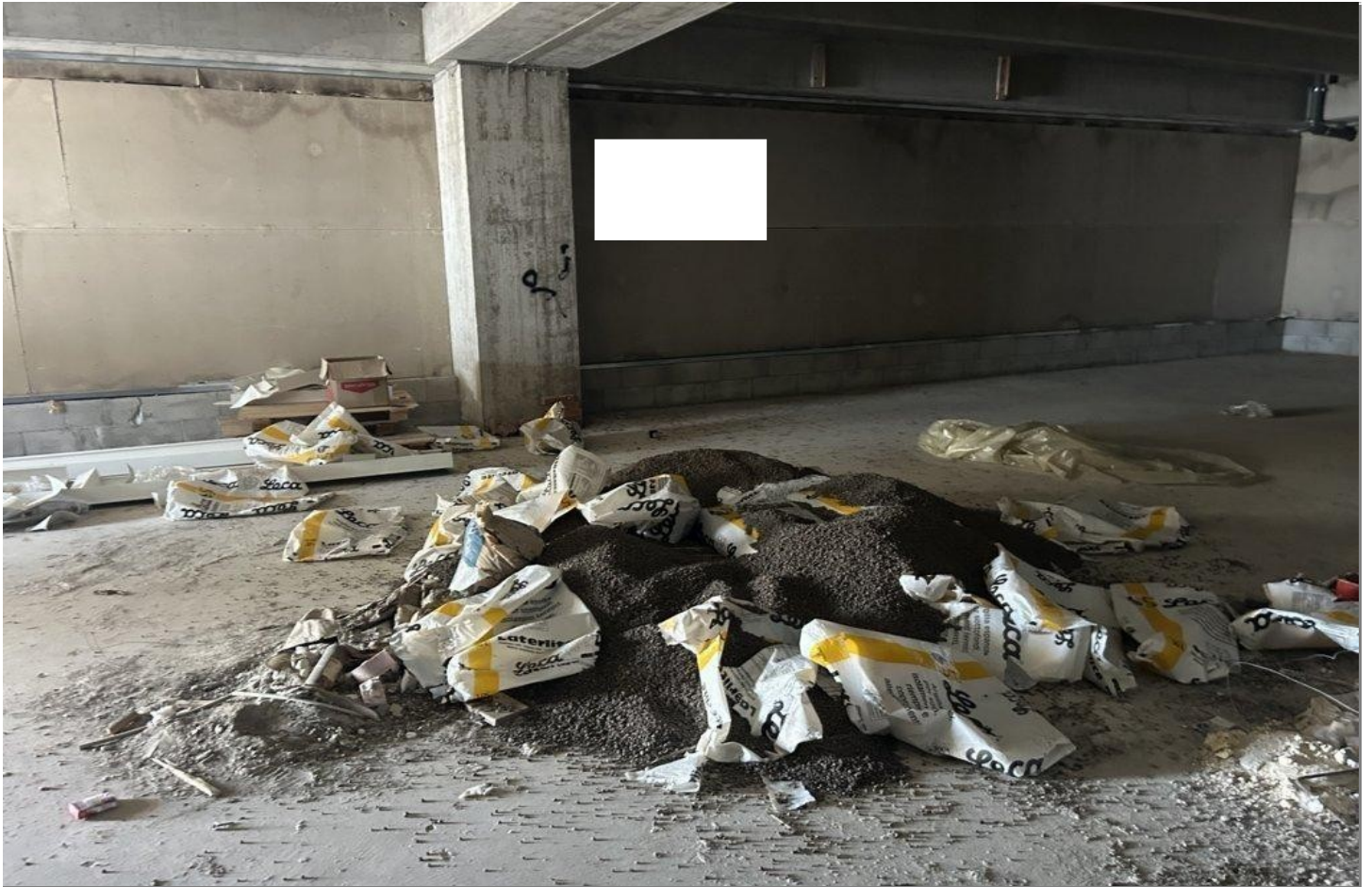
Interno p.lla 1359 sub.8 e 9
