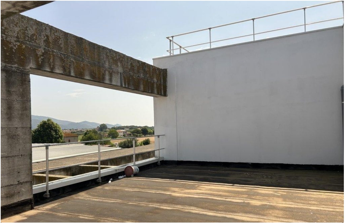
Esterno p.IIa 152 sub.16
