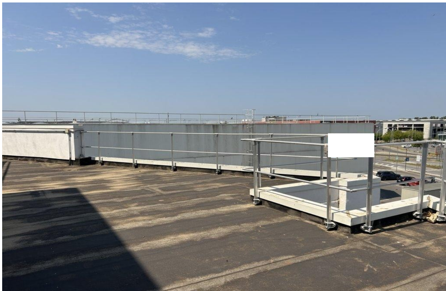
Esterno p.IIa 152 sub.16
