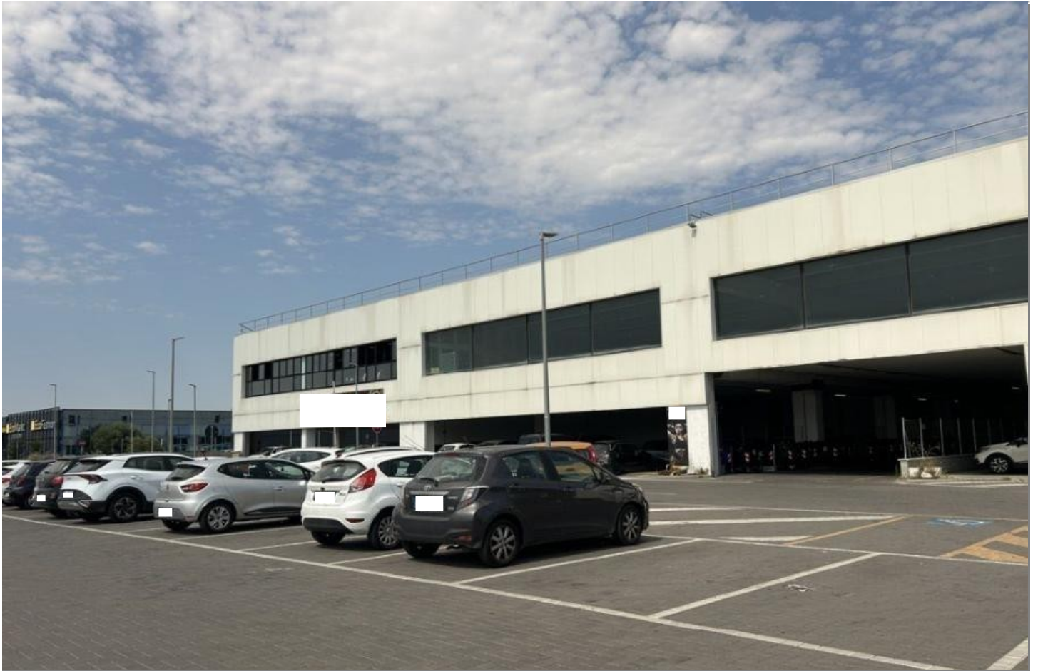
Esterno p.IIa 152 sub.12
