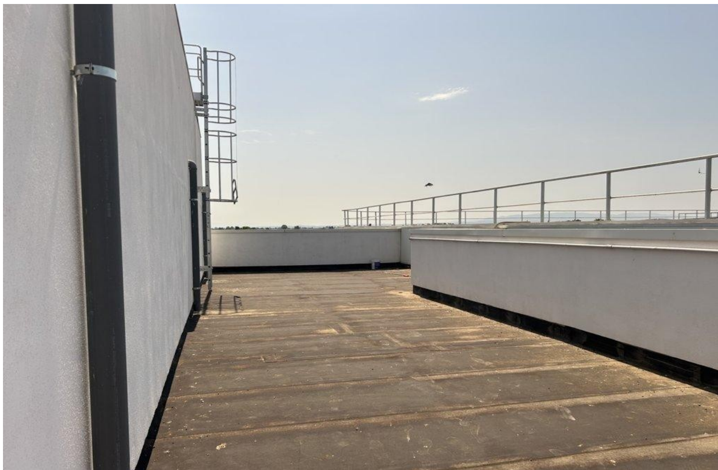
Esterno p.IIa 152 sub.16
