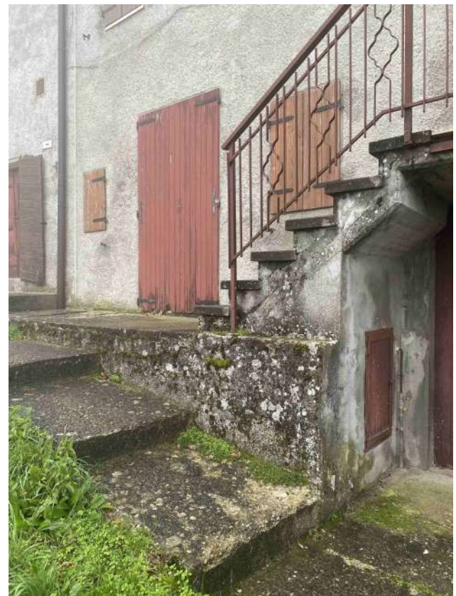
Figura 4: facciata - particolare scala esterna
