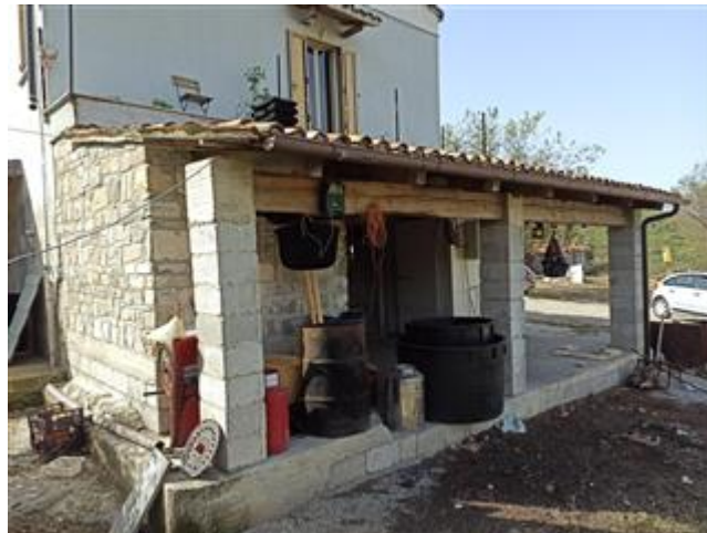
Esterno - tettoia laterale
