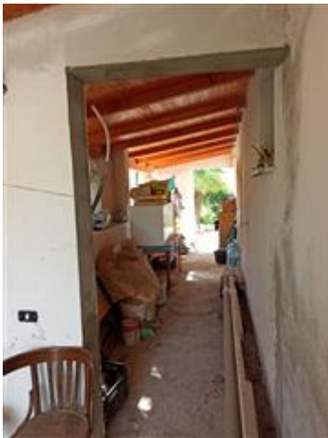
Esterno - tettoia lato posteriore
