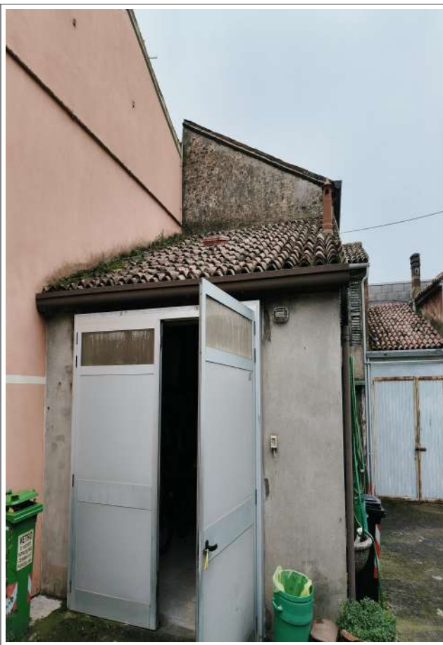
Veduta esterna del garage dal cortile interno
