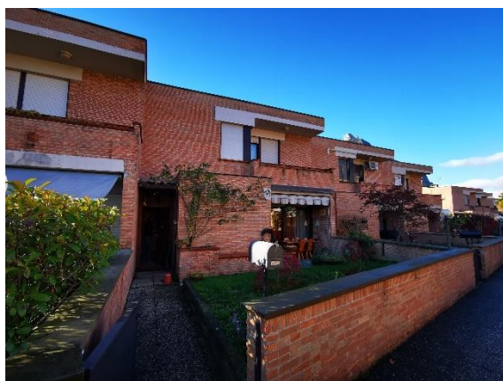
Facciata principale, ingresso da vialetto pedonale condominiale
