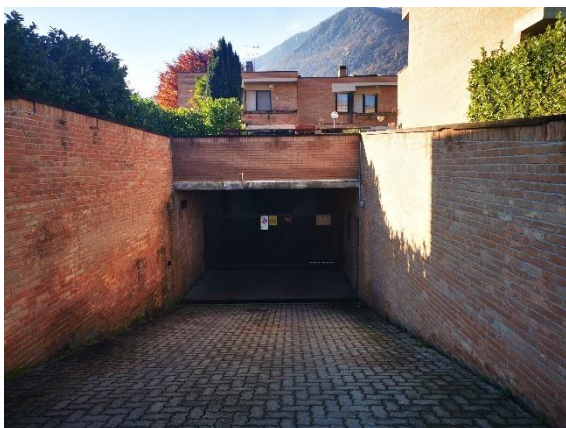
Rampa condominiale di accesso ai box da Via G. Ferrero
