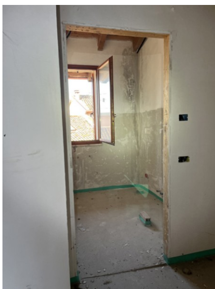
interni piano Terra/1°
