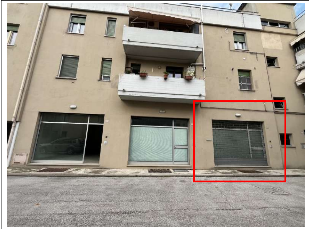
FOTO N. 1 – Vista fronte (via degli Olivi)
