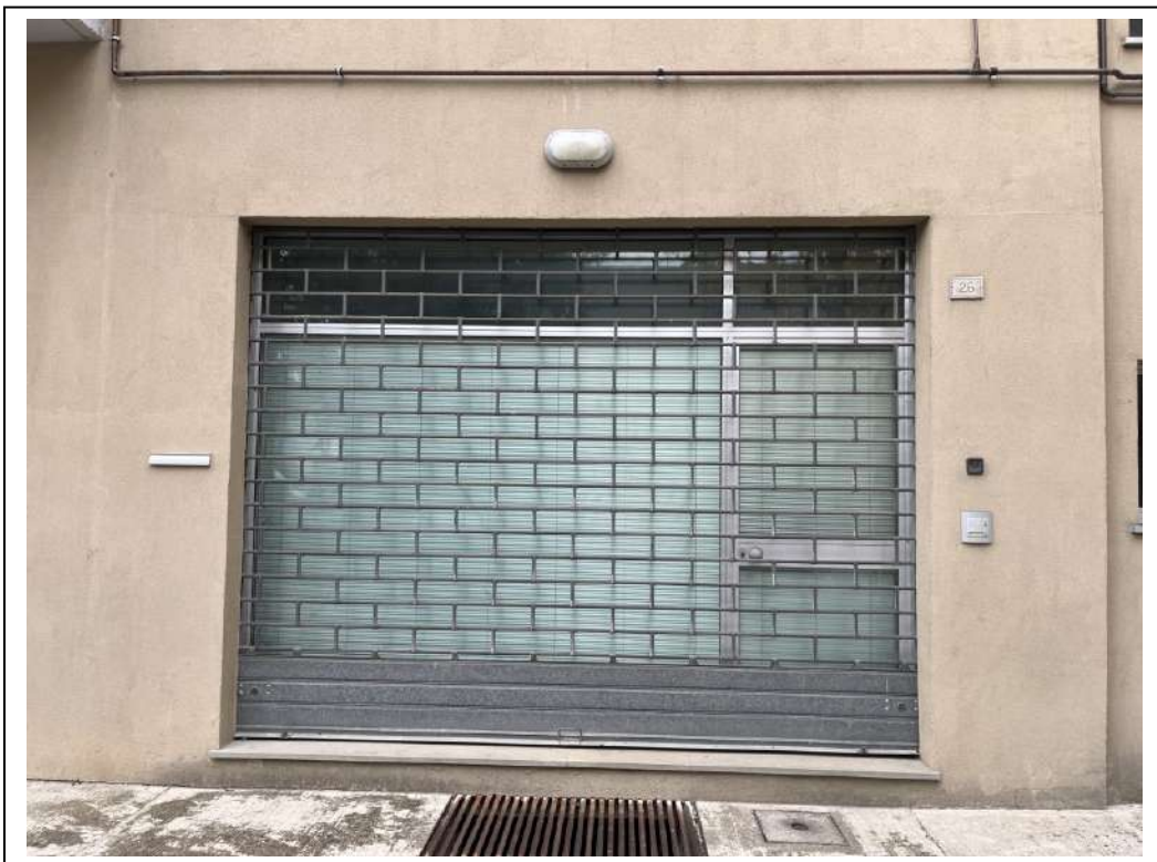
FOTO N. 2 – Vista fronte (via degli Olivi)
