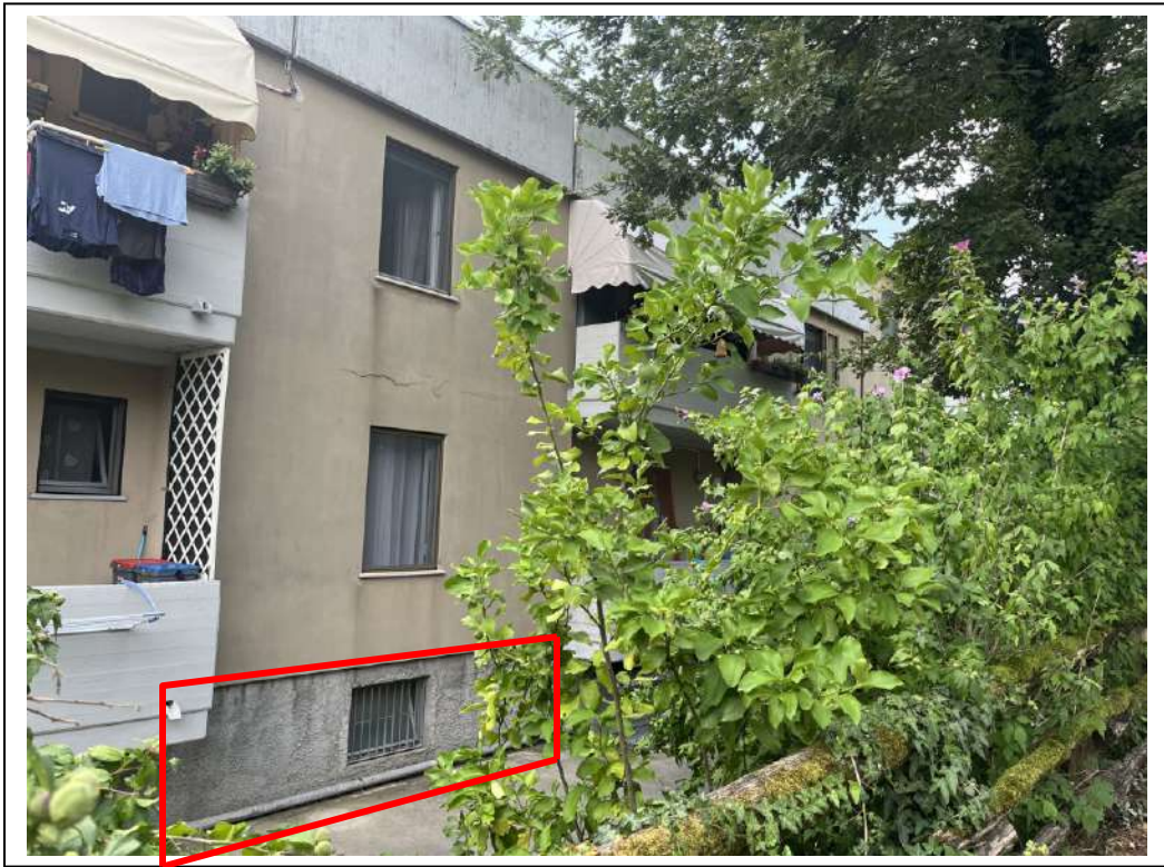
FOTO N. 3 – Vista retro (via delle Querce)
