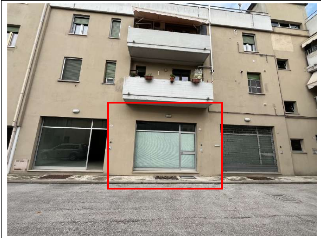
FOTO N. 1 – Vista fronte (via degli Olivi)
