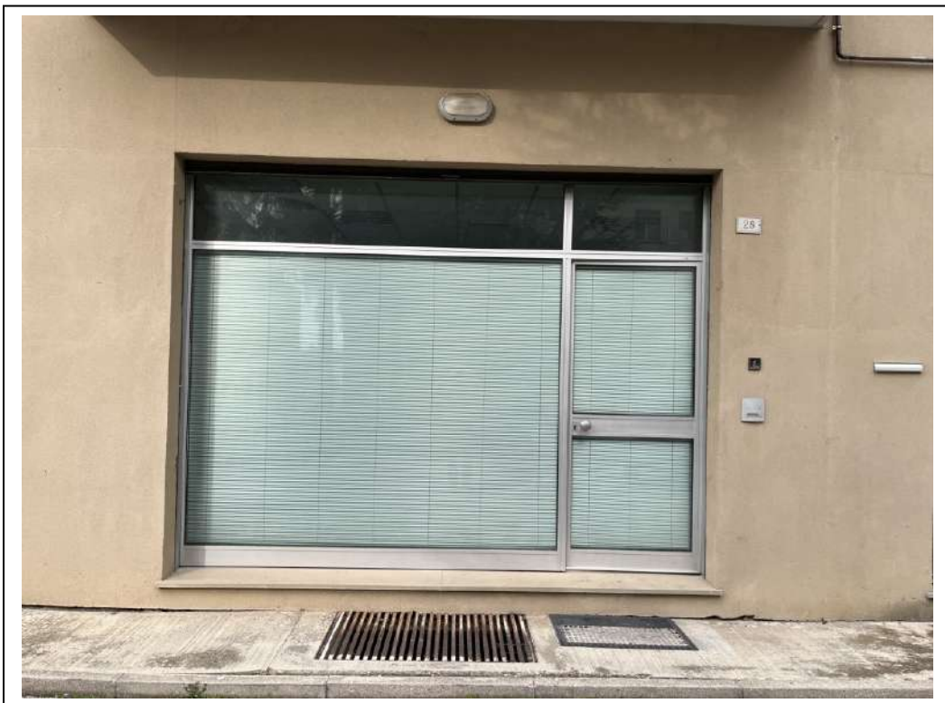
FOTO N. 2 – Vista fronte (via degli Olivi)
