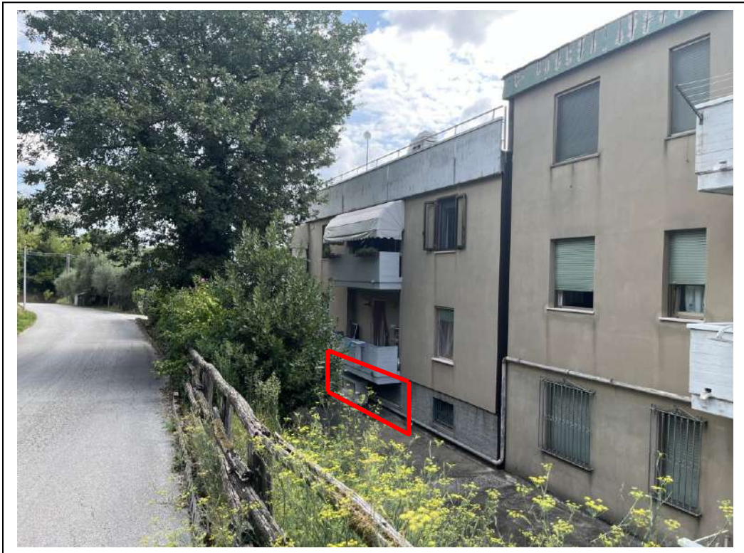
FOTO N. 3 – Vista retro (via delle Querce)
