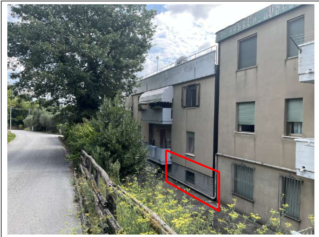
FOTO N. 3 – Vista retro (via delle Querce)
