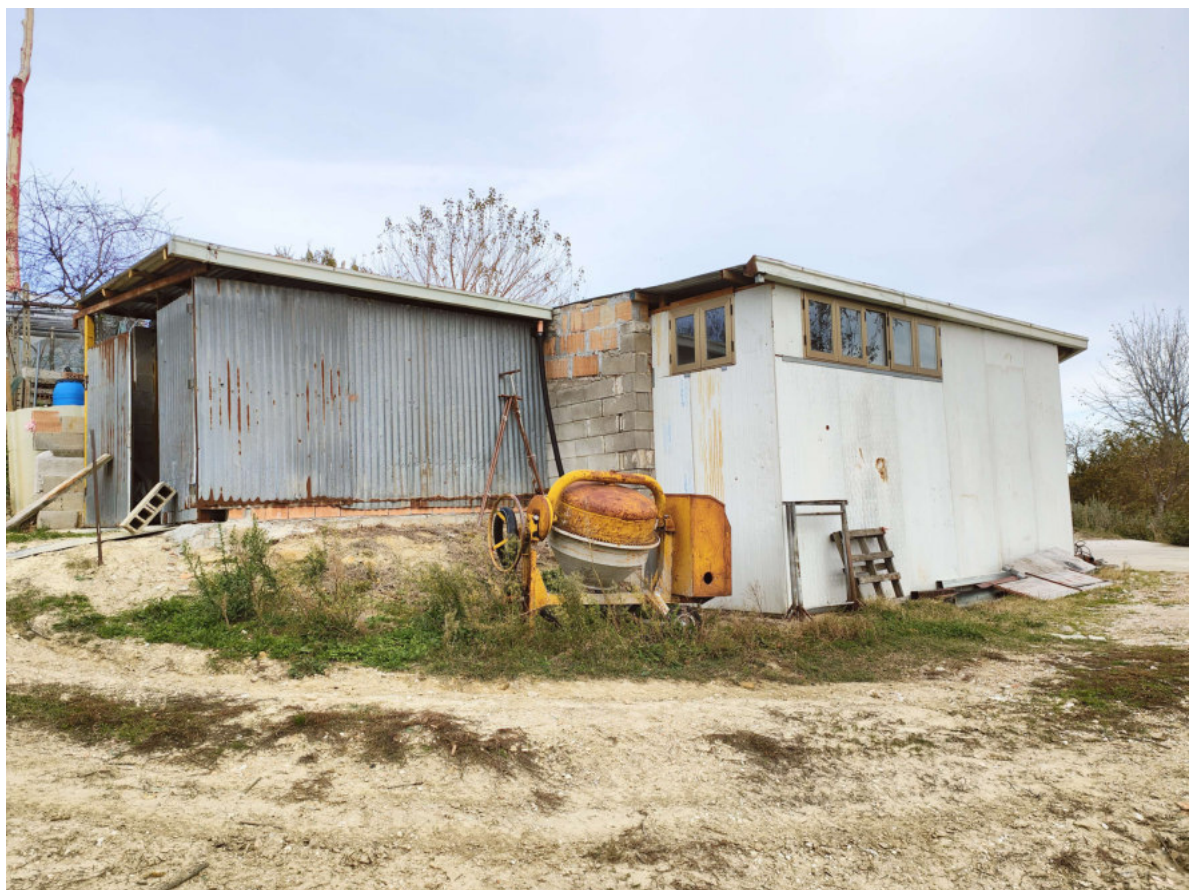
10) Struttura precaria (2-3) da rimuovere
