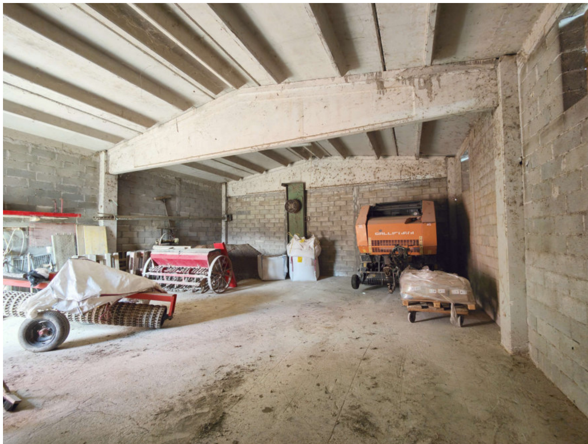
05) Fabbricato per usi agricoli - Vista interna
