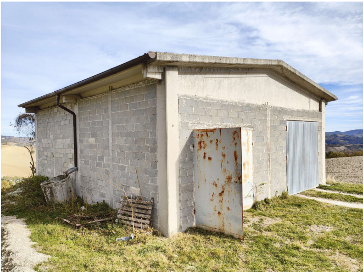
04) Fabbricato per usi agricoli - Fianco sinistro
