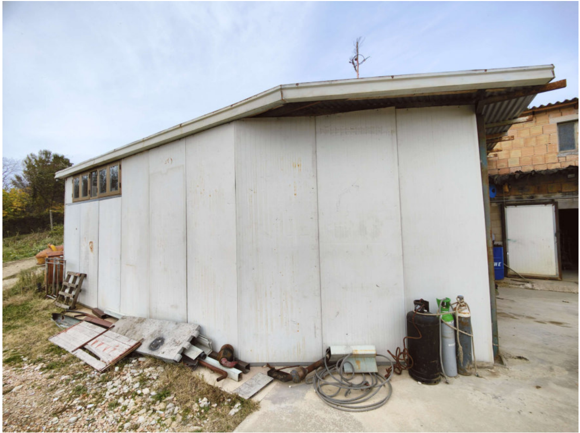
11) Struttura precaria (3) da rimuovere
