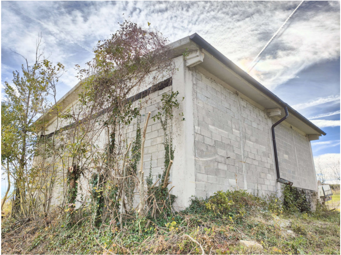
03) Fabbricato per usi agricoli - Retro
