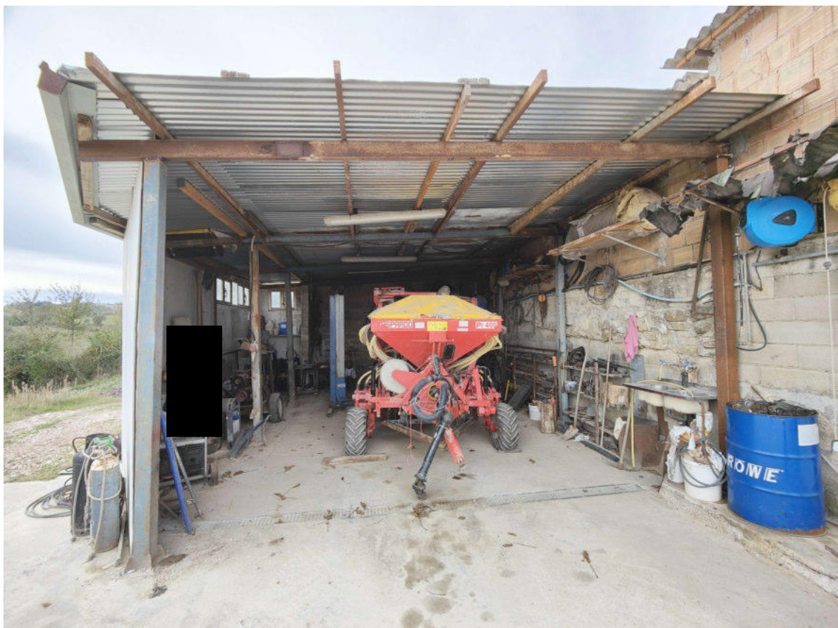
04) Struttura precaria per ricovero attrezzi - dettaglio
