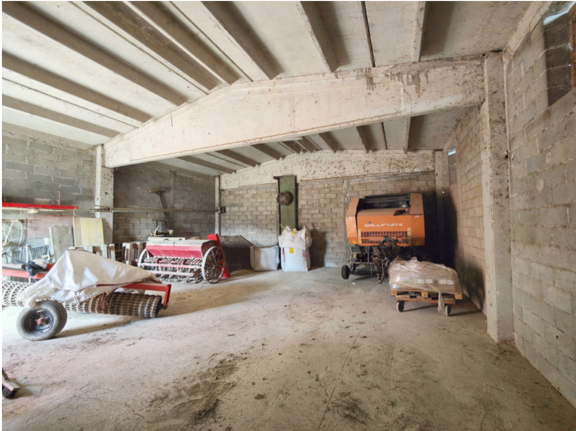
05) Fabbricato per usi agricoli - Vista interna
