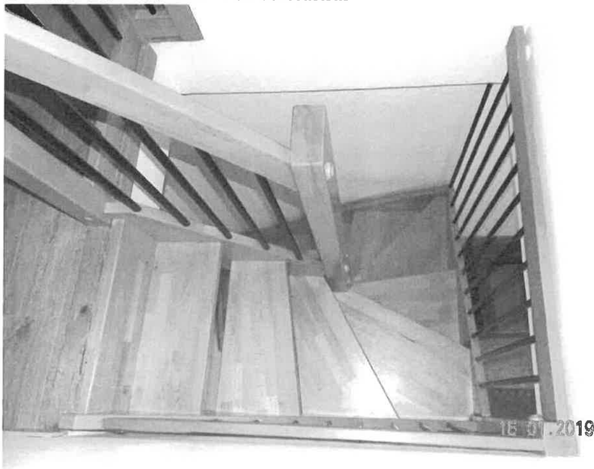
LOTTO 2 - Piano sottotetto - Vista della scala interna
