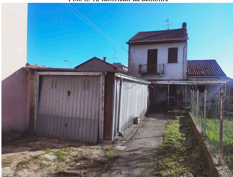
Foto n. 12 fabbricati da demolire
