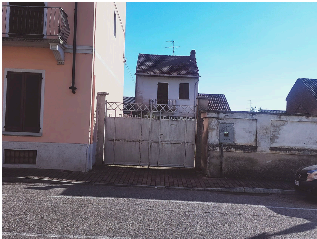
FOTO N° 1 facciata lato strada
