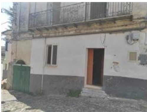
Ingresso da Via Interzati
