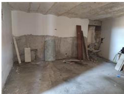
Interno vano principale
