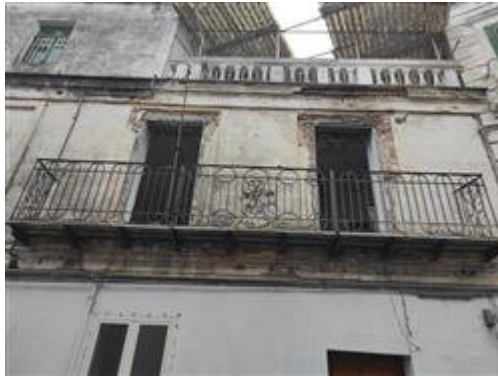
Particolare balcone aggettante su Via Interzati
