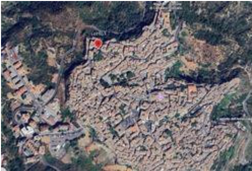
Ortofoto generale Area Urbana "Centro storico di Rossano"
