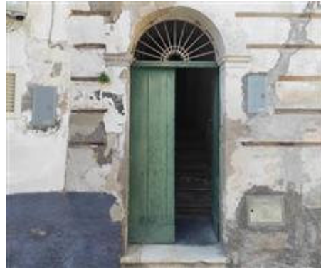
Portone d'ingresso vano scala comune - Via Interzati n. 8
