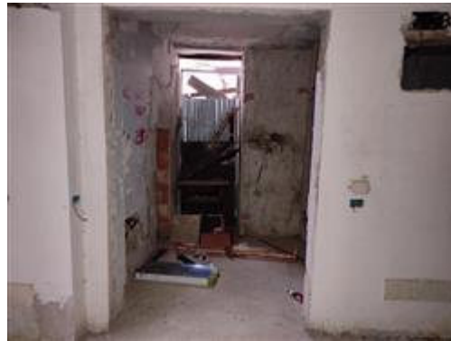
Accesso Disimpegno / Porta su Vicolo Primo Via Interzati
