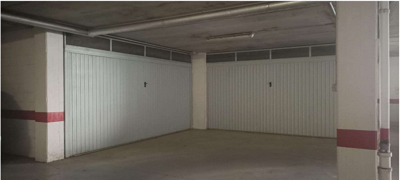
Foto n.15: Particolare dei due garages al secondo piano interrato.
