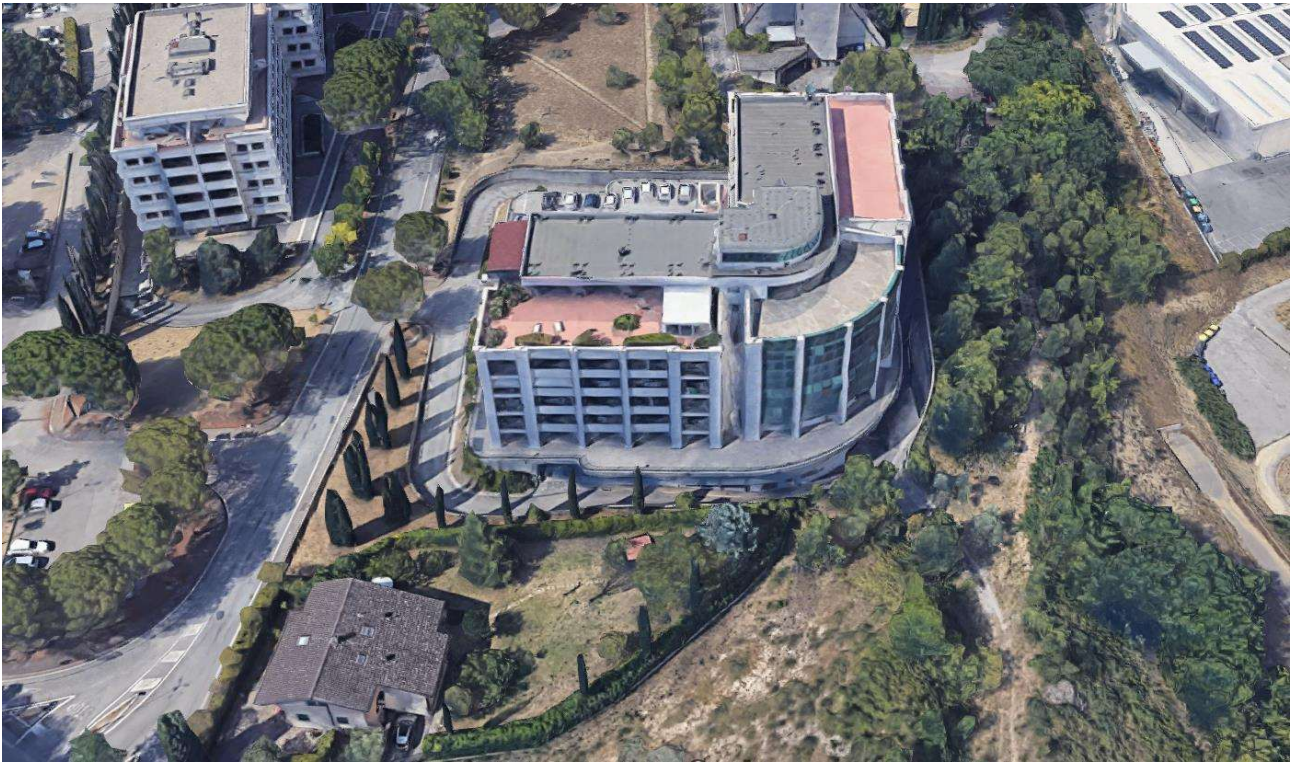
Foto n.1: Veduta del fabbricato del complesso denominato “Il Panorama 2”, sito a Perugia in via G.B. Pontani 3/9 e costituito da tre corpi di fabbrica, contraddistinti con le lettere A-B-C, destinati in prevalenza ad attività direzionali, in parte a residenza e parte a casa riposo per anziani con tre piani interrati destinati per gran parte ad autorimesse e locali vari. La porzione eseguita costituita dagli uffici ai piani terzo e quarto appartengono al corpo centrale “B”.
