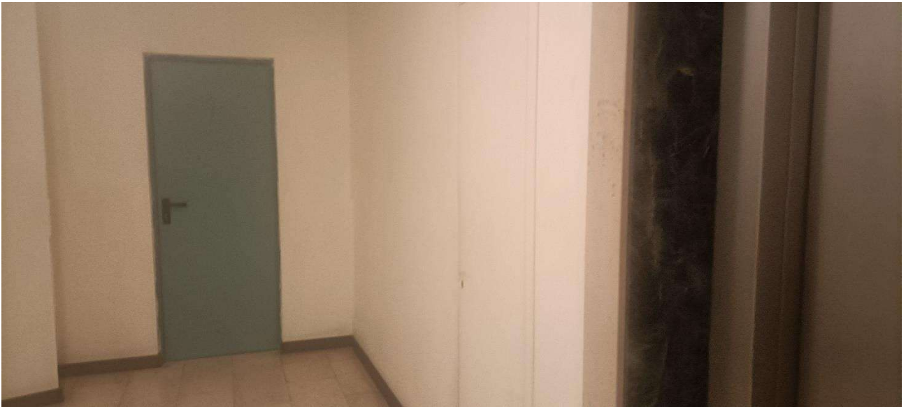
Foto n.13: Particolare del portoncino di accesso al locale archivio al secondo piano interrato.
