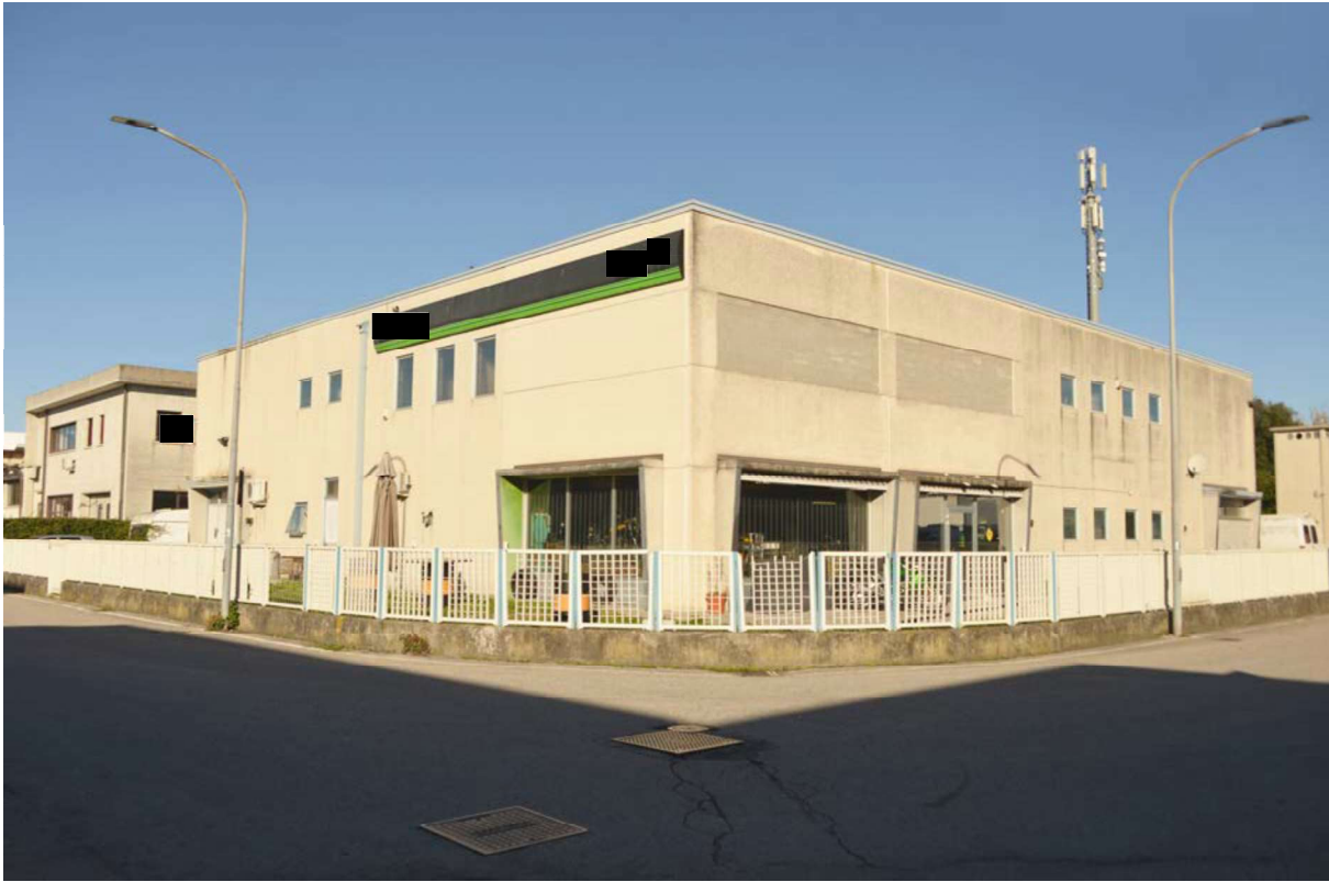
Foto n. 1 – Fronte Nord Est del lotto su Via A. Gentilin
