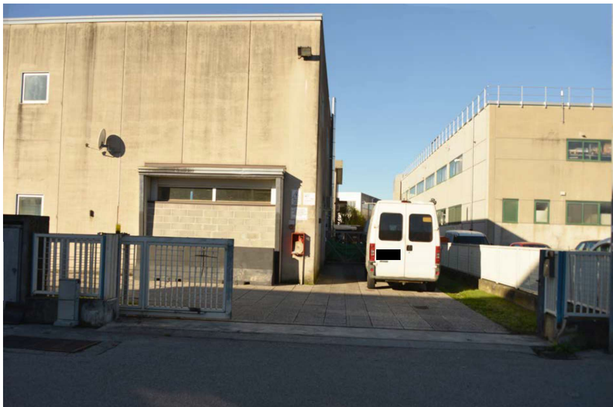
Foto n. 18 – Ingresso carraio fronte Est
