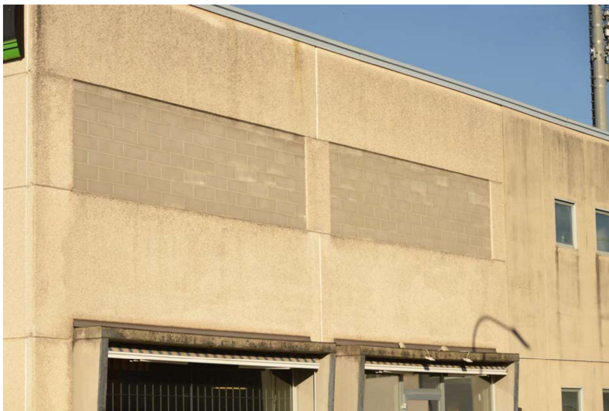
Foto n. 19 – Particolare chiusura terrazza fronte Sud
