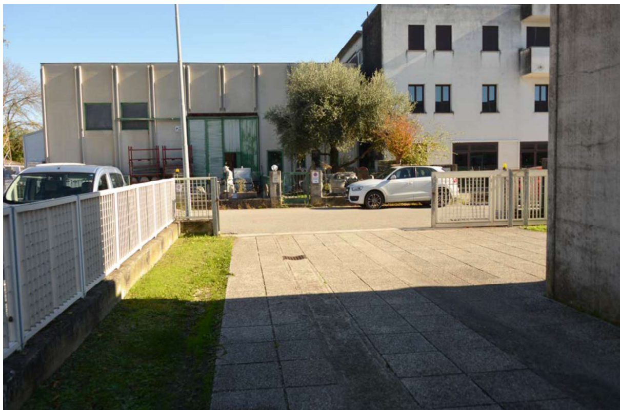
Foto n. 13 – Ingresso carraio da lato Sud
