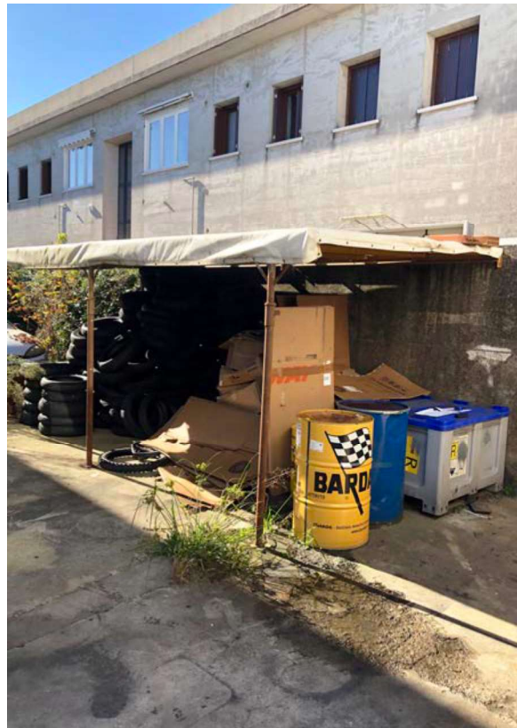
Foto n. 30 - Lato Ovest - Pergolato difforme
