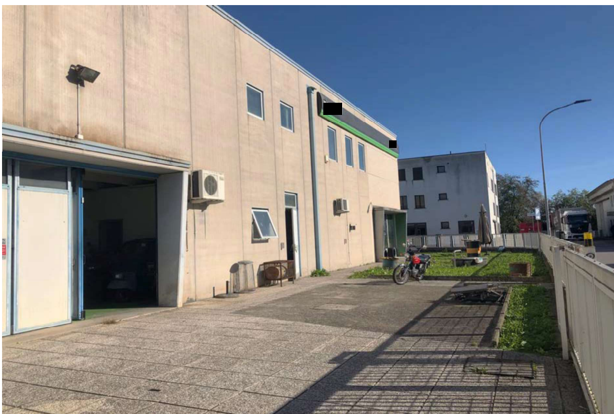
Foto n. 22 – Area scoperta lato Sud su ingresso zona officina
