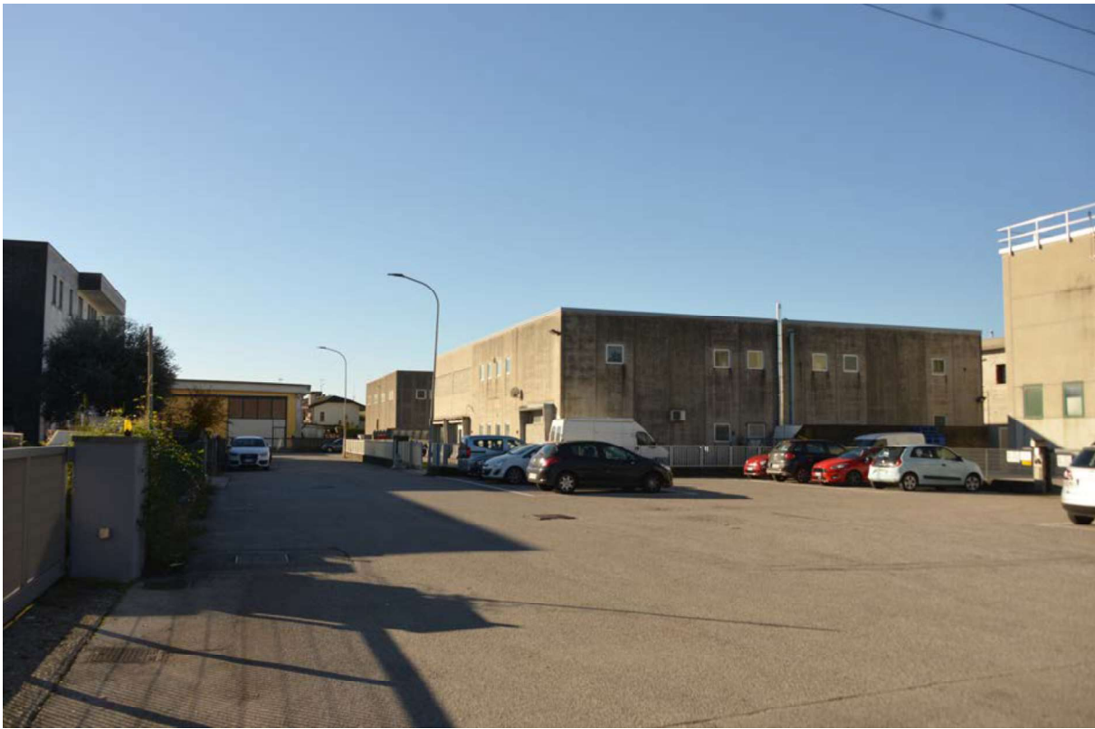
Foto n. 5 – Fronte Sud Est Via A. Gentilin
